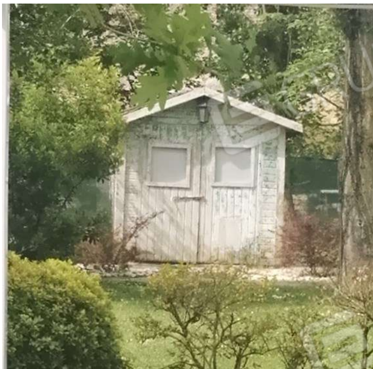
Foto particella 229 - Rimessa
