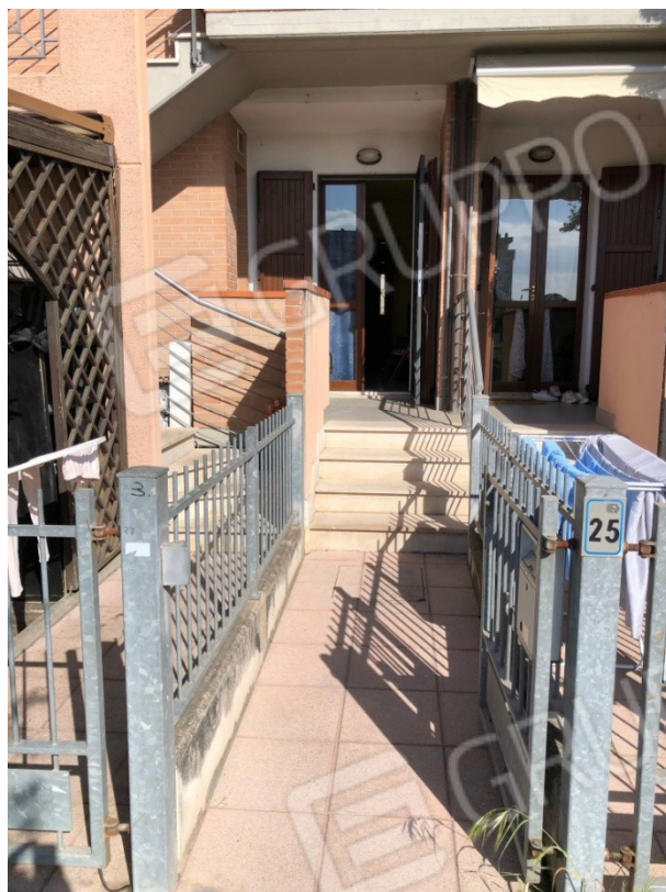
Vista da Via Castelli, accesso dal corsello pedonale. Vista area cortiliva esclusiva e balcone
