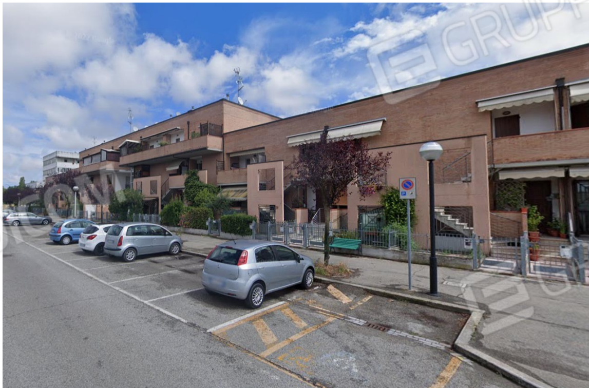
Vista generale dell'edificio fronte strada.
