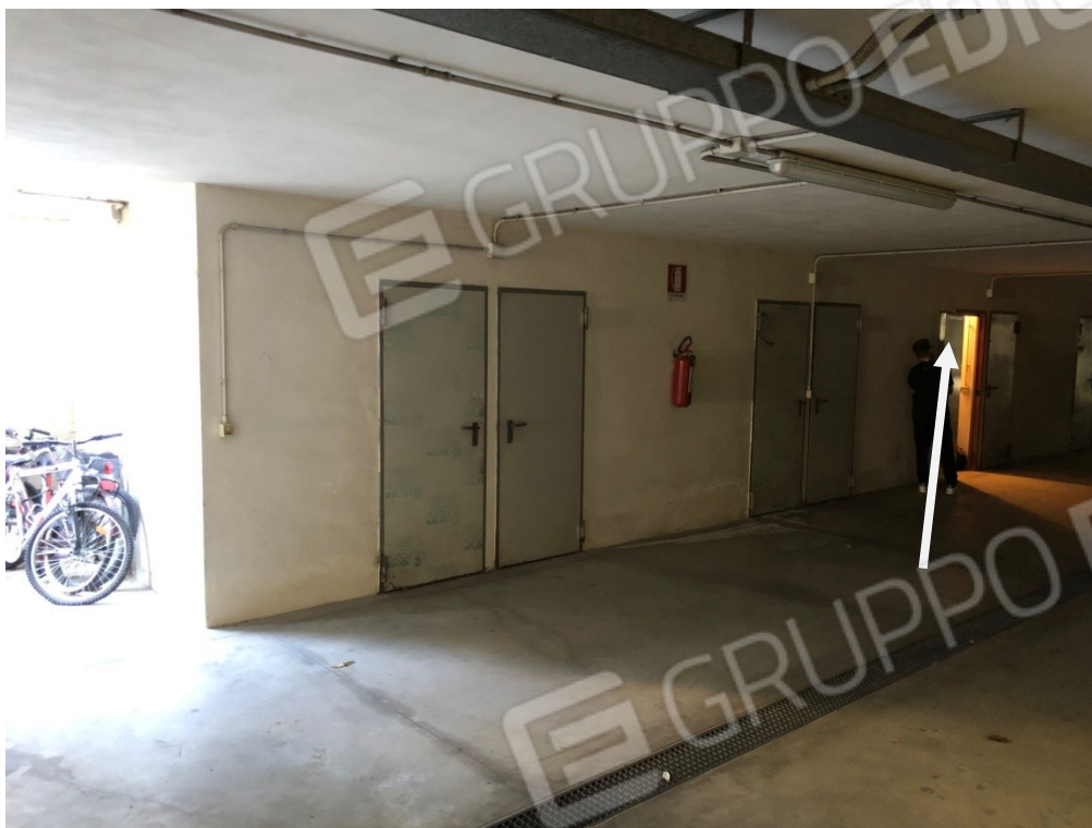
Vista cantina al piano interrato
