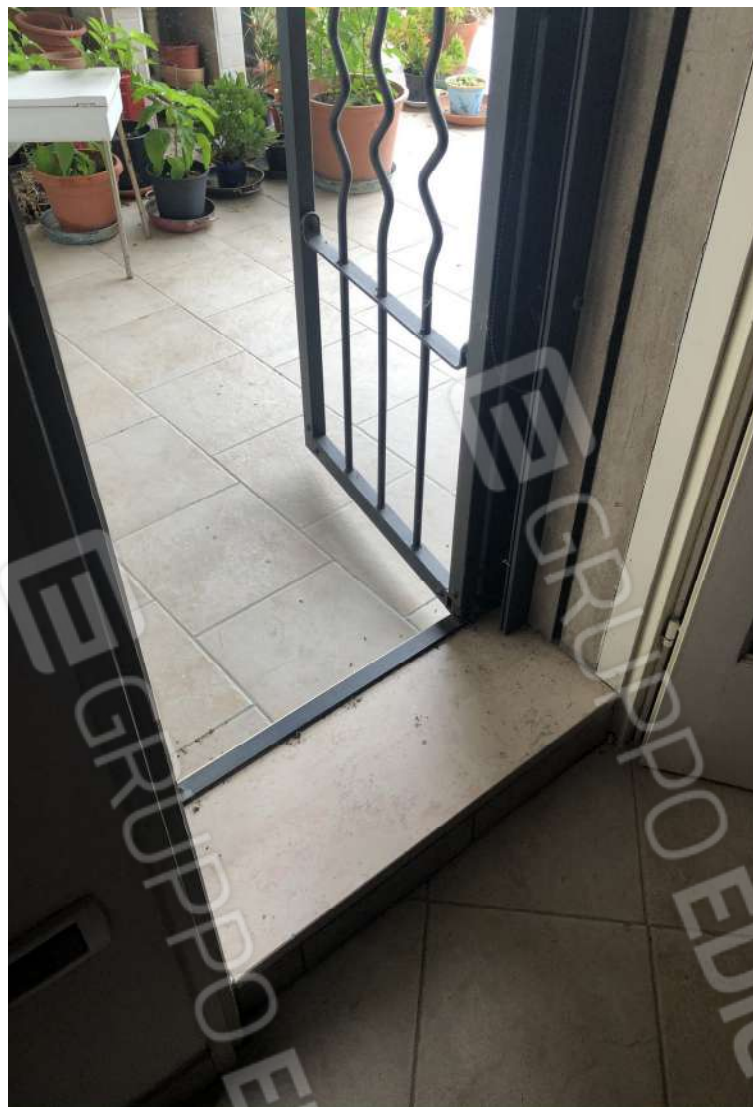
Foto 22: Particella 105, Subalterno 3, piano 1
