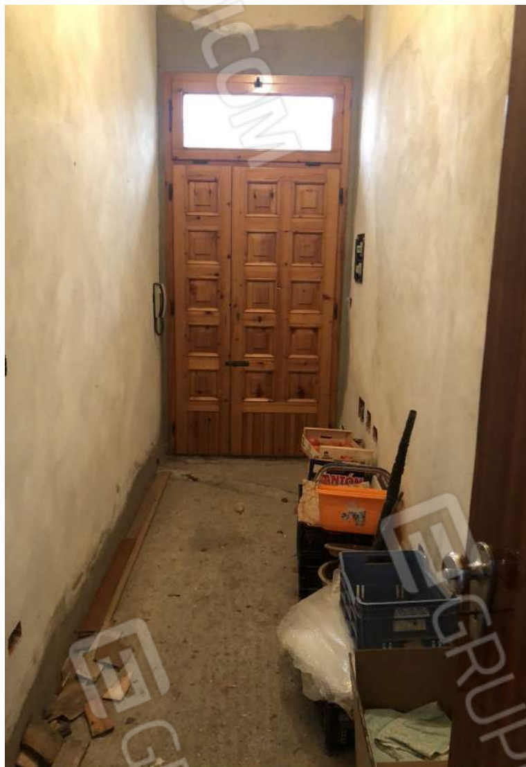
Foto 5: Particella 105, Subalterno 3, piano T
