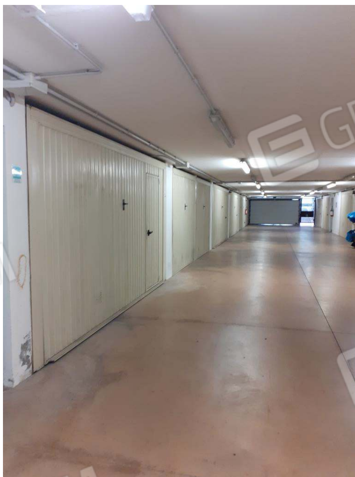
CORSIA CARRABILE ALL'INTERNO DELLA RIMESSA AL PIANO SOTTOSTRADA
