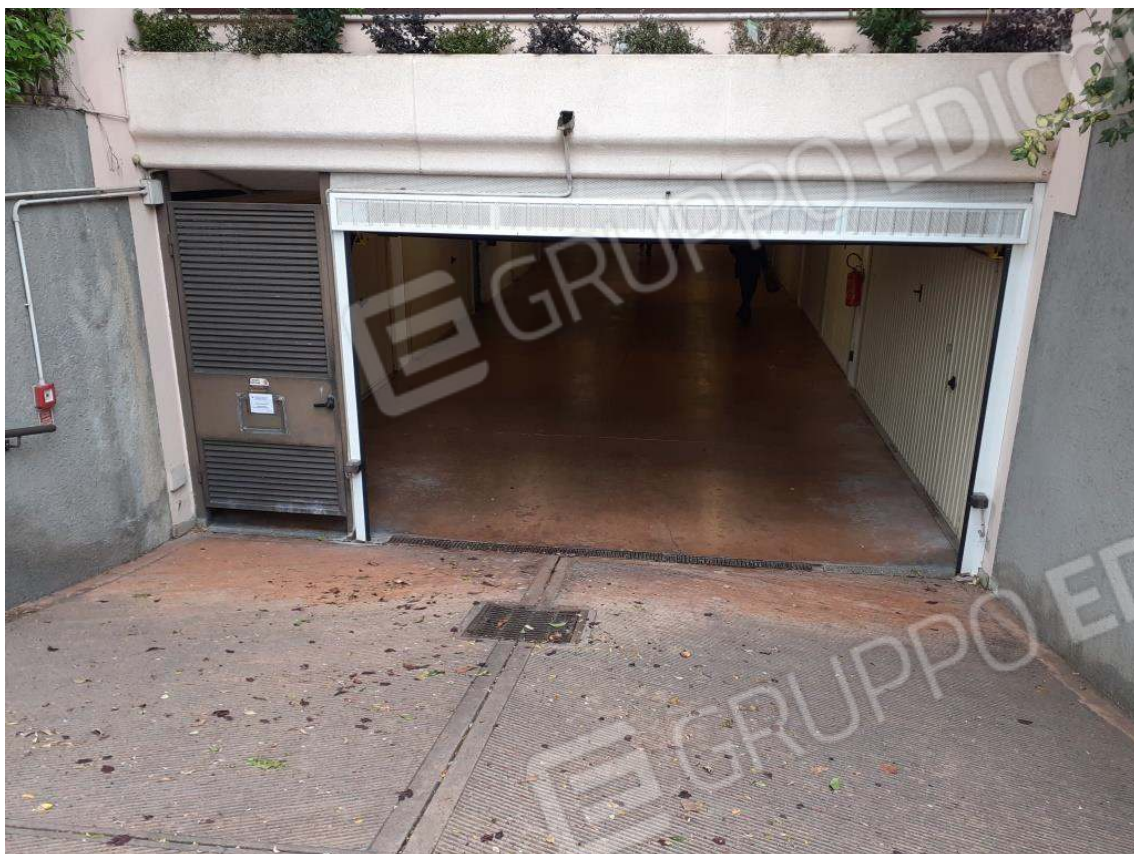
INGRESSO DELLA RIMESSA INTERRATA AL PIANO SOTTOSTRADA
