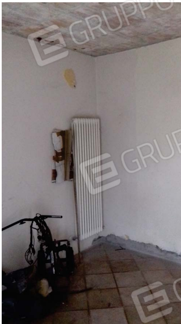
FOTO 6 RIPOSTIGLIO COLLEGATO ALLA MONOSTANZA PIANO TERRA
