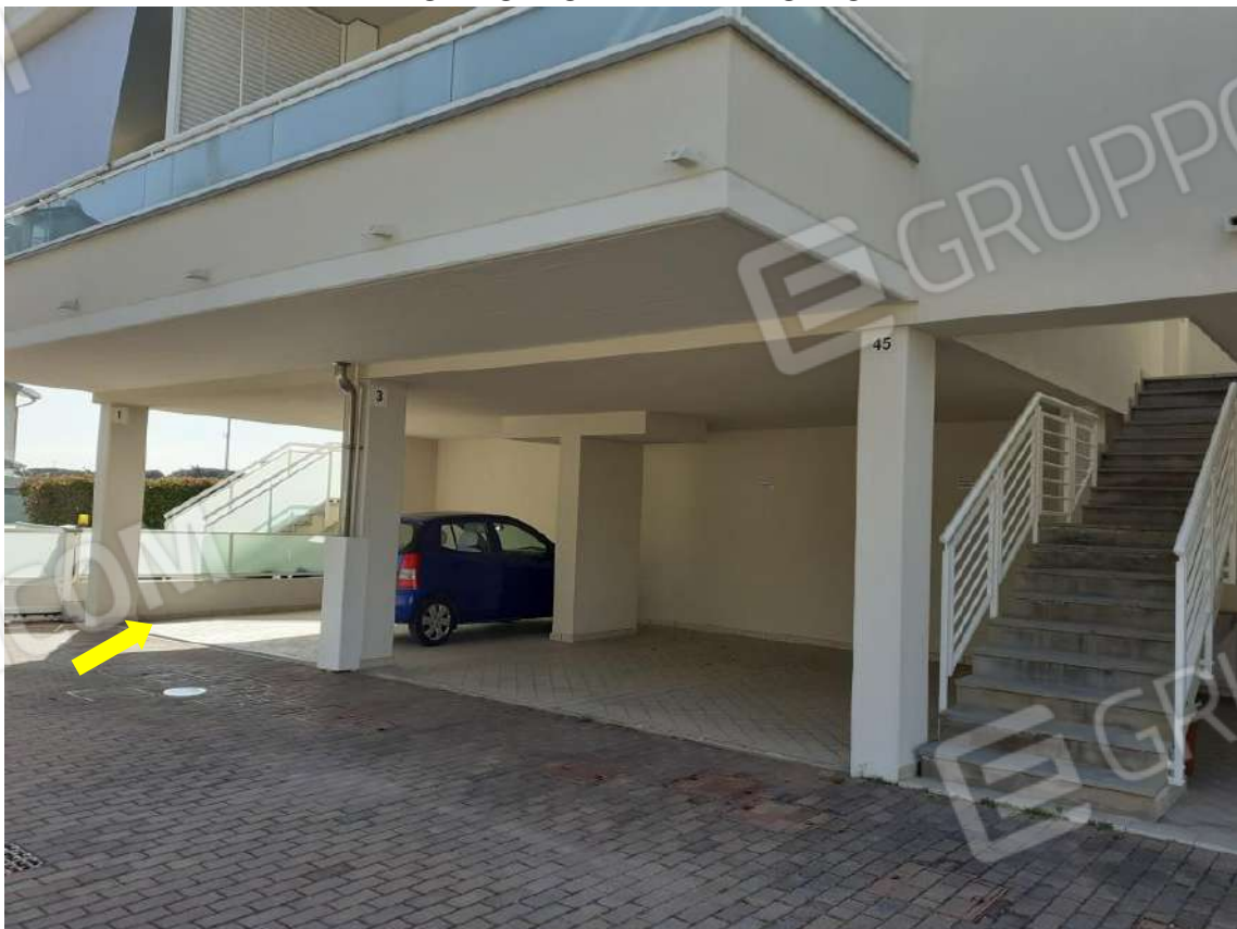
SUB 58 POSTO AUTO COPERTO NEL PORTICATO DEL FABBRICATO "B"
