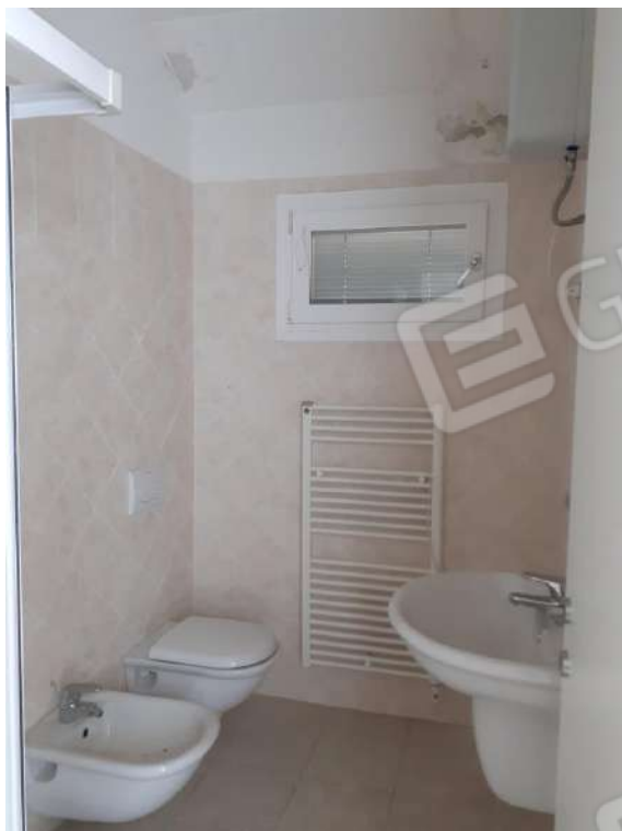
SUB 6 INTERNO: BAGNO E PARTICOLARI PROBLEMATICHE UMIDITA'
