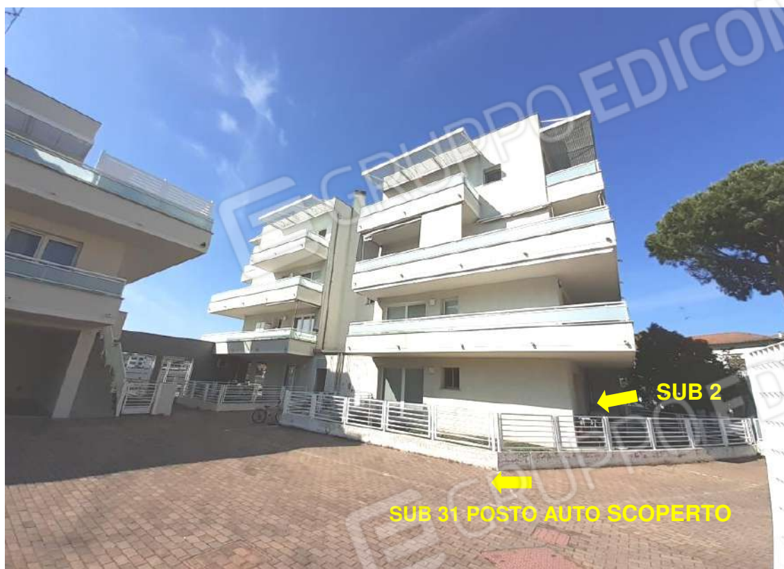
VISTA FABBRICATO "A" DAL CORTILE INTERNO – UBICAZIONE DEL SUB 2 E DEL SUB 31 POSTO AUTO SCOPERTO NELLA CORTE
