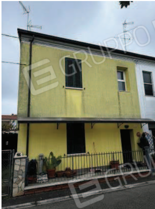
Foto 1: Fabbricato fronte su via Casona
