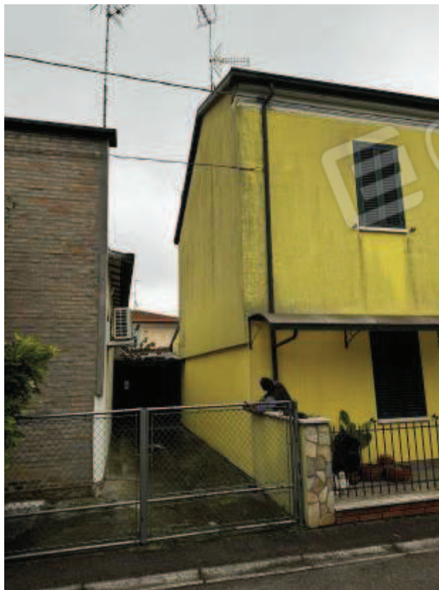
Foto 2: Fabbricato fronte su via Casona
