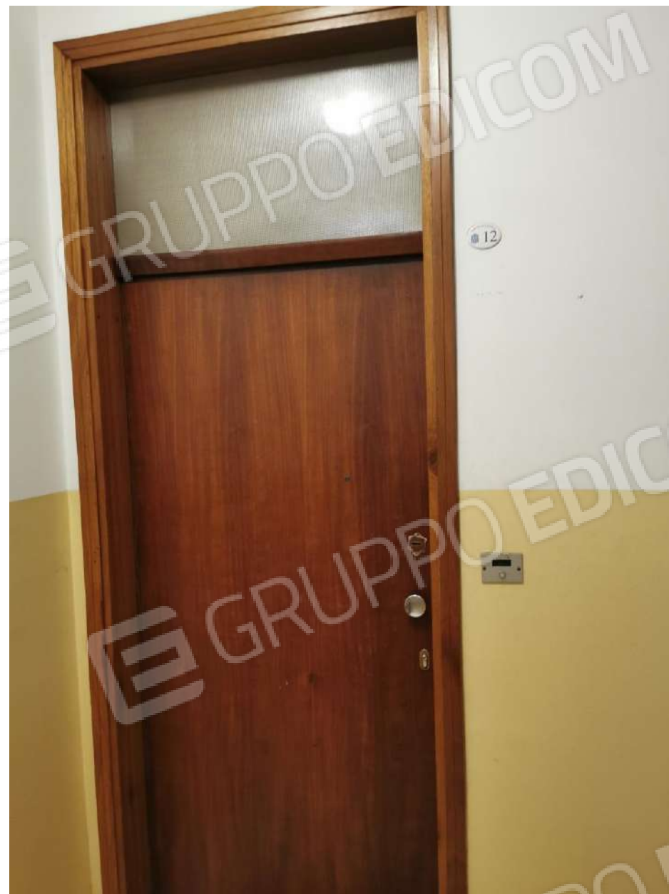
porta ingresso appartamento
