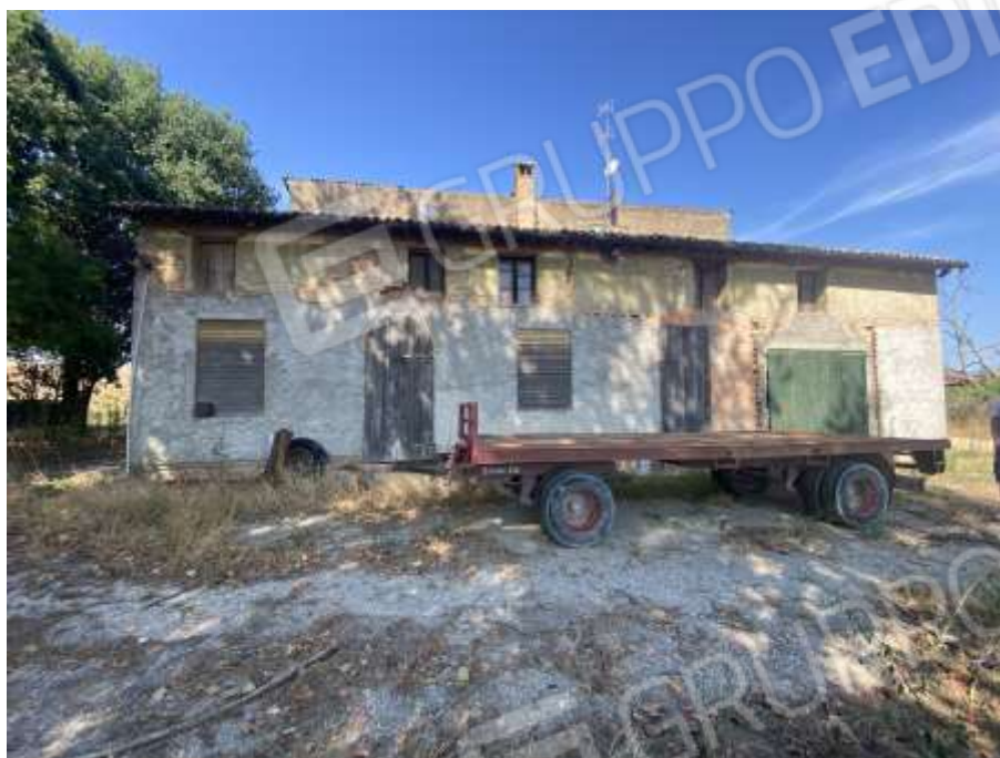
Facciata unità abitativa sub 1
