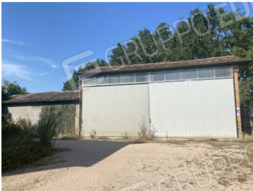
Capannone agricolo facciata lato abitazione
