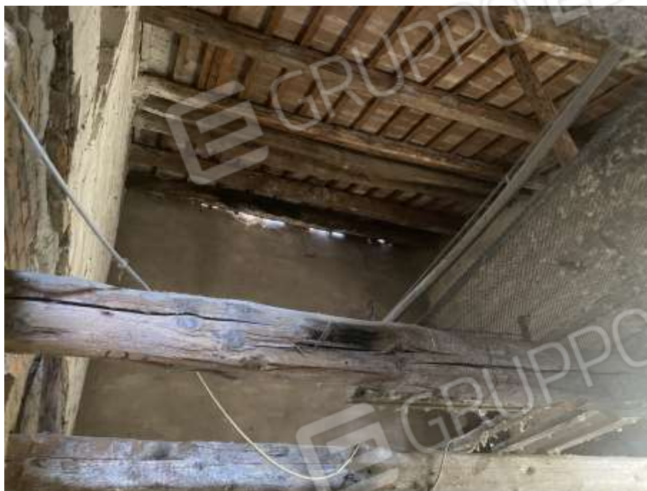
Interno unità abitativa sub 1 –solaio parzialmente demolito
