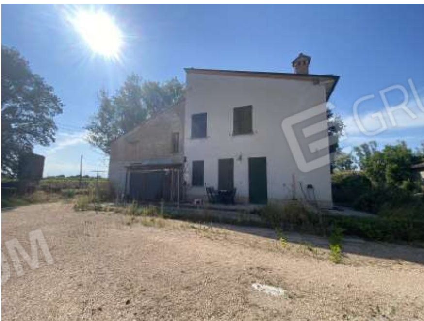
Facciata unità abitativa sub 2
