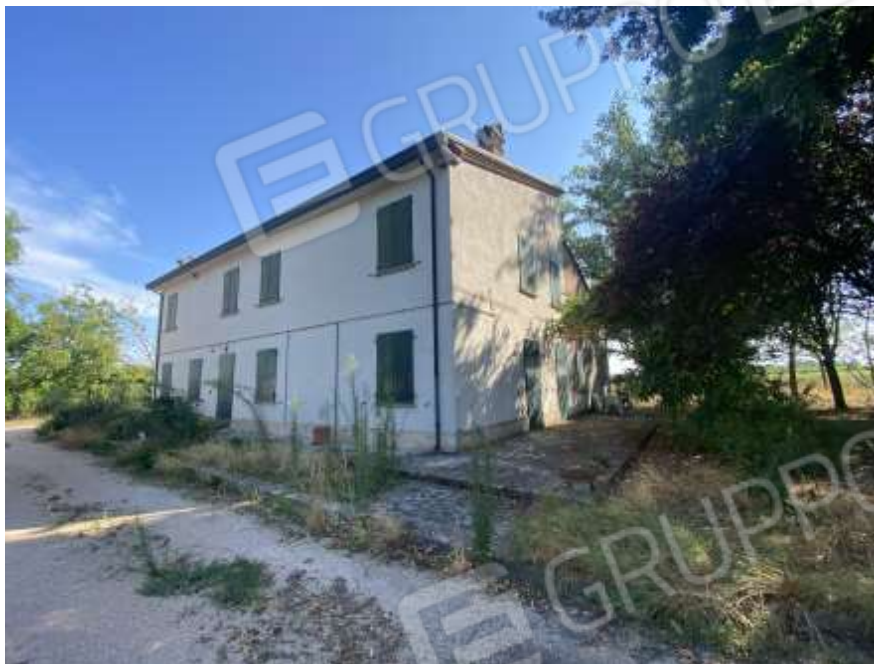
Facciata unità abitativa sub 2
