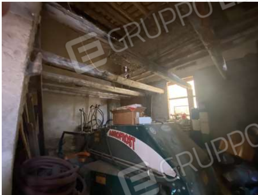
Interno unità abitativa sub 1 – solaio parzialmente demolito
