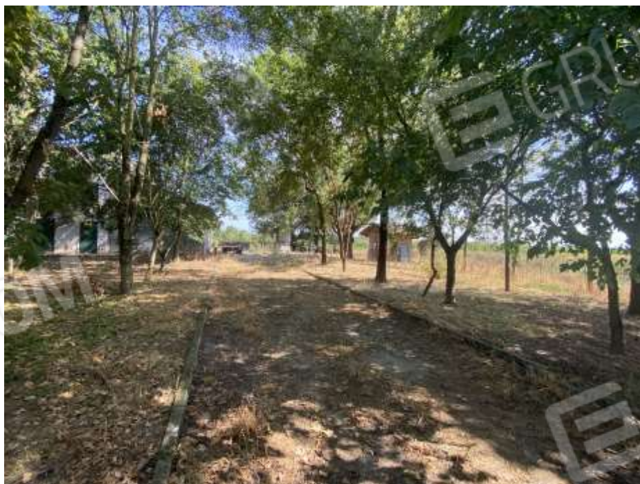
Viabilità interna al lotto da ingresso secondario verso unità sub 1 con lavori al grezzo
