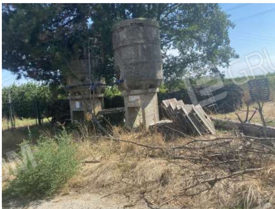
Cisterne prive di autorizzazioni
