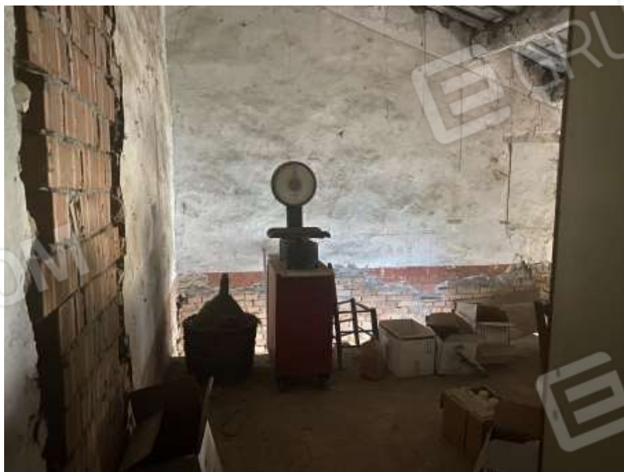
Interno piano primo unità abitativa sub 1
