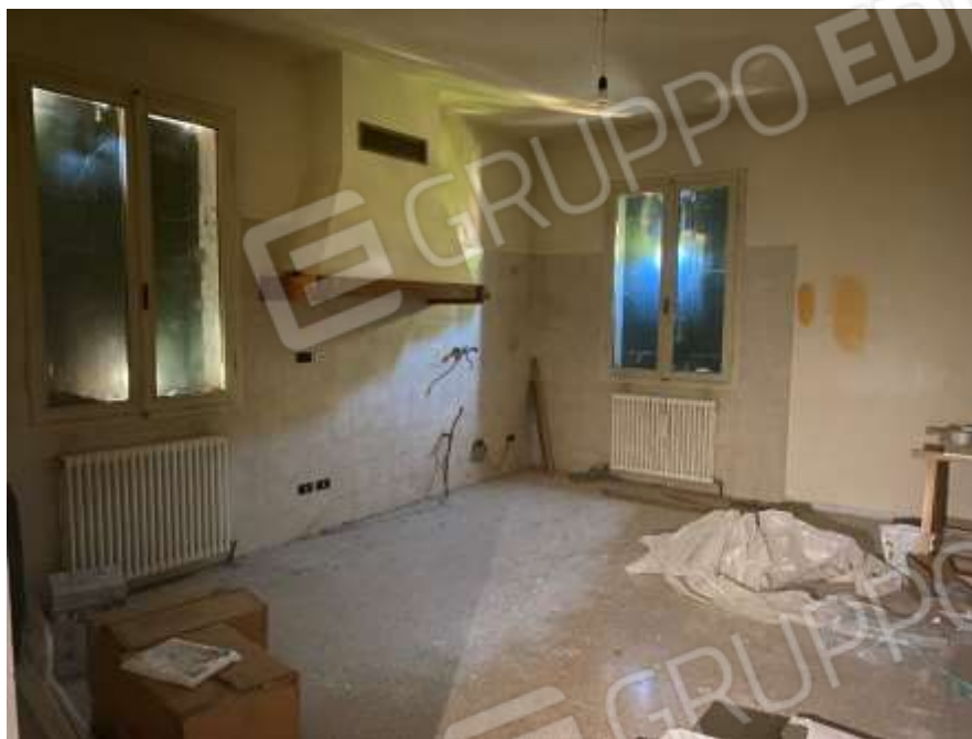
Interno piano primo unità abitativa sub 2 – cucina di servizio
