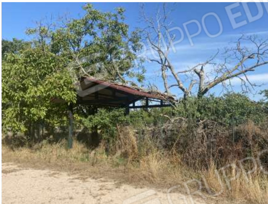
Tettoia priva di autorizzazioni
