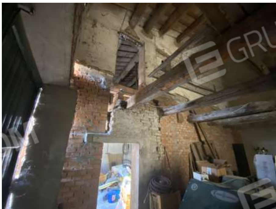
Interno unità abitativa sub 1 – solaio parzialmente demolito
