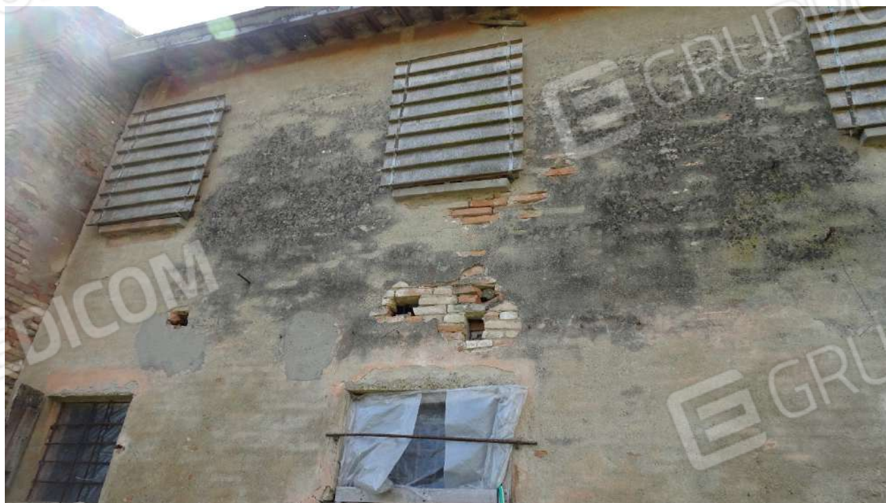
Foto 08_particolare muro esterno
