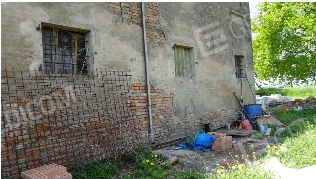
Foto 10_particolare muro esterno
