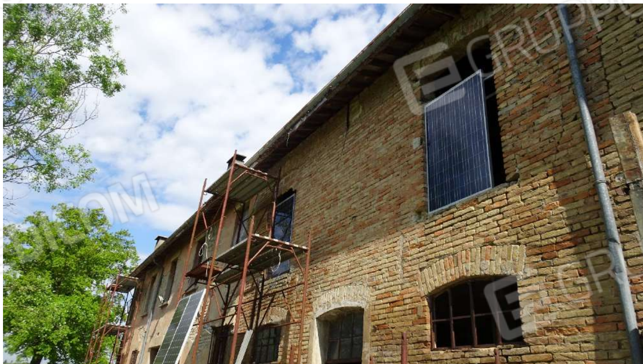
Foto 02_particolare prospetto principale
