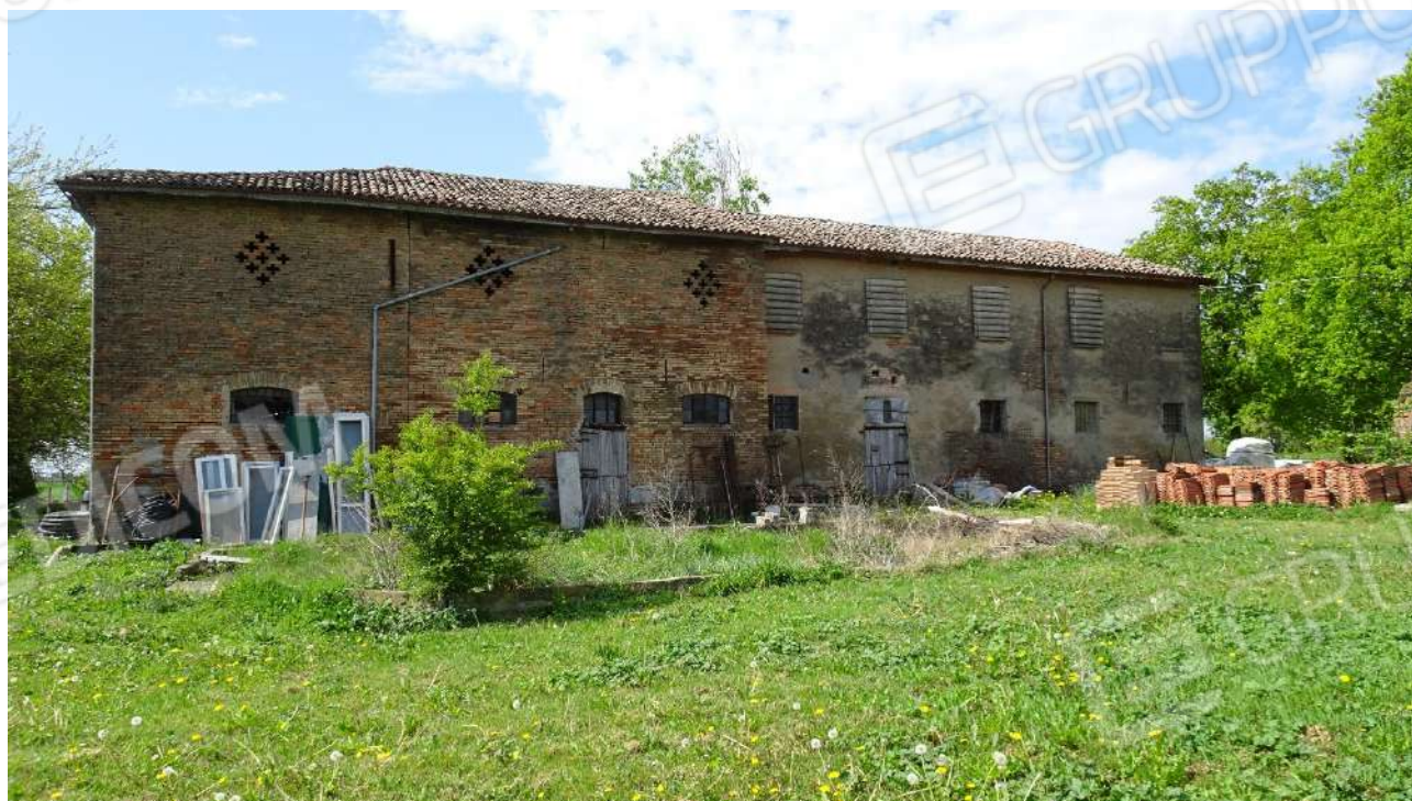
Foto 06_prospetto principale retro
