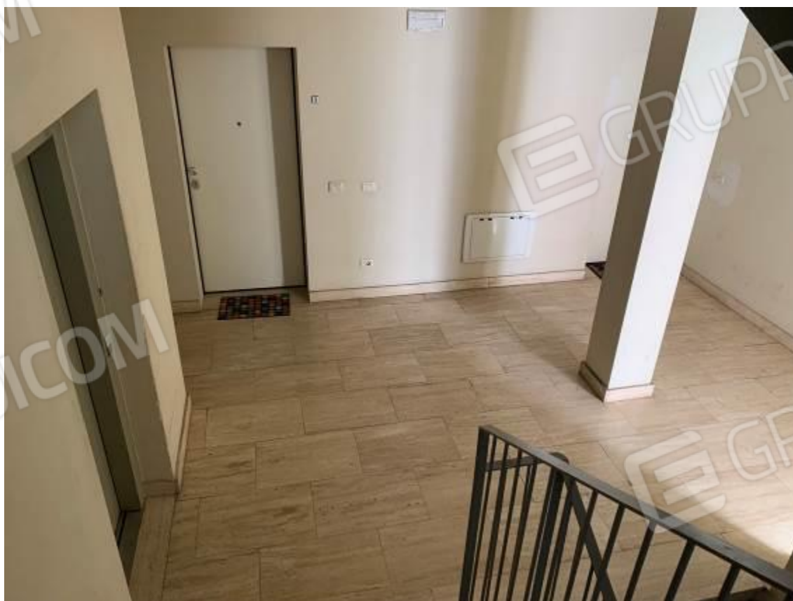
Foto 16: Parti comuni – Fabbricato B
