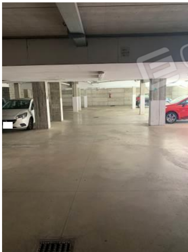
Foto 33: Passaggio carrabile comune – Fabbricato B
