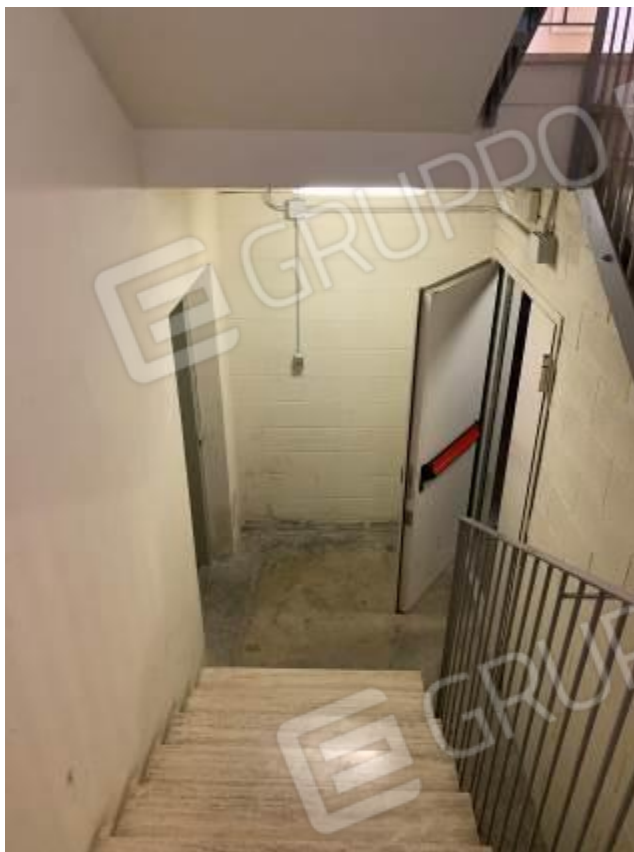
Foto 17: Parti comuni – Fabbricato B
