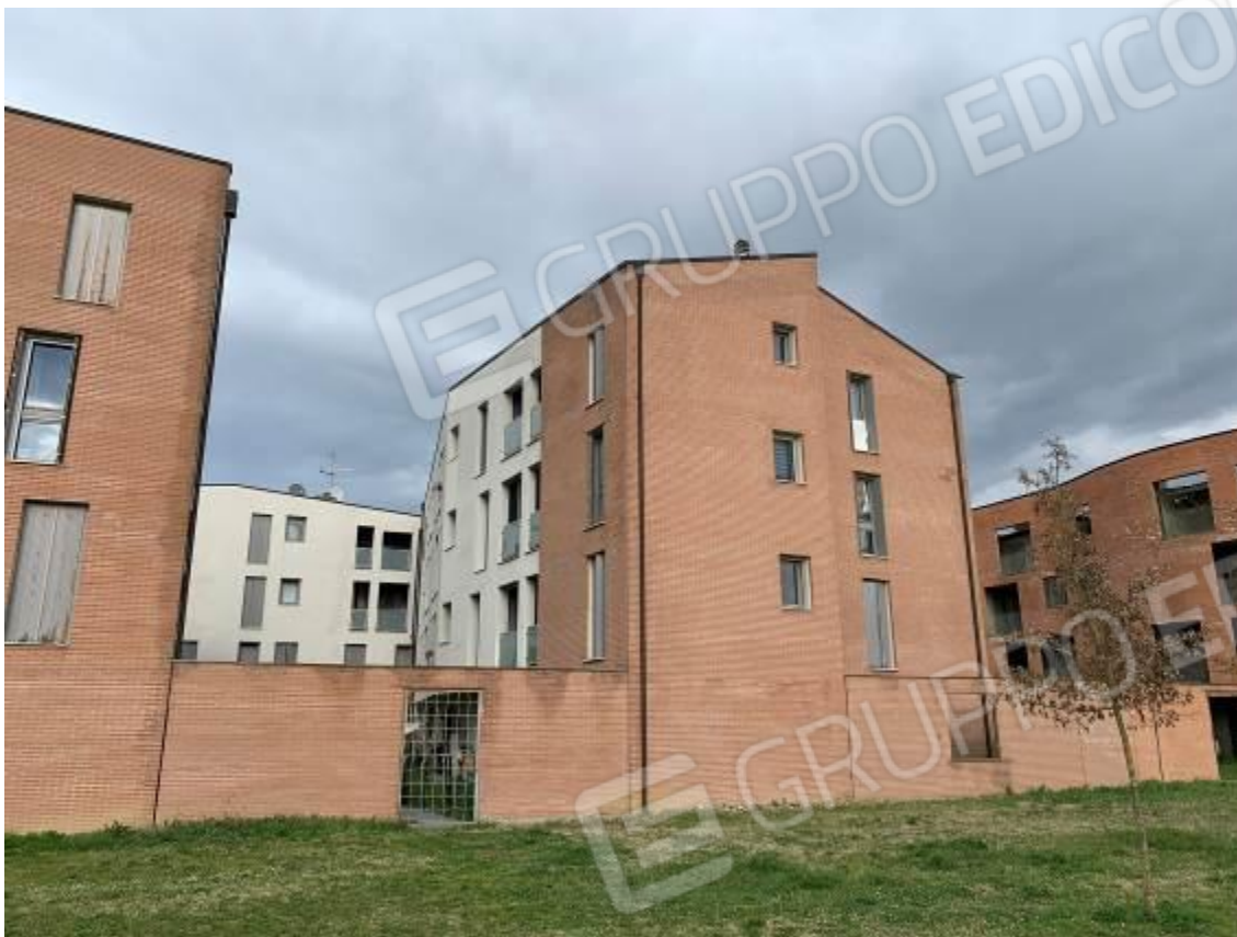
Foto 7: Esterni – Fabbricato B
