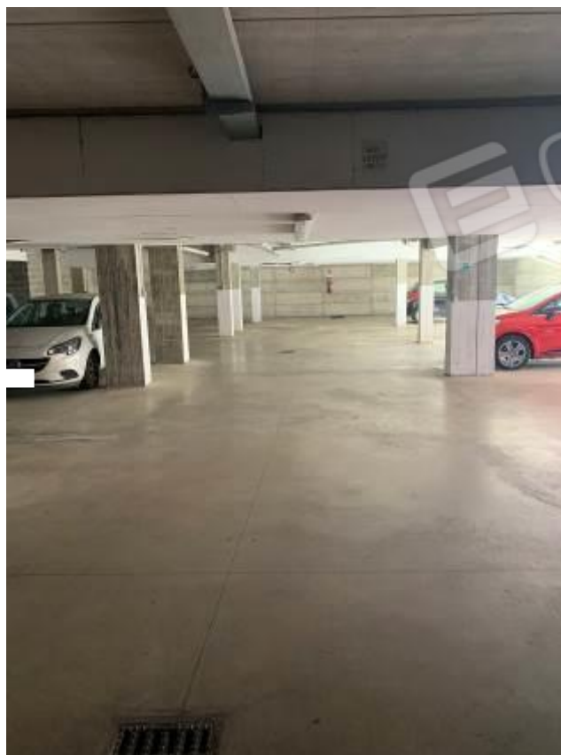
Foto 33: Passaggio carrabile comune – Fabbricato B
