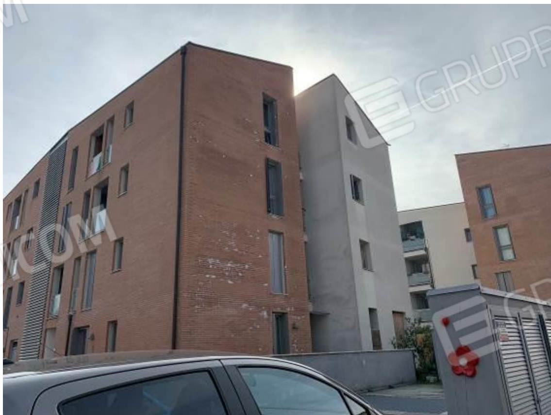
Foto 4: Esterni – Fabbricato B
