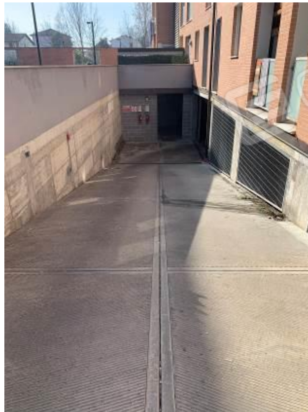
Foto 31: Accesso ai garage – Fabbricato B
