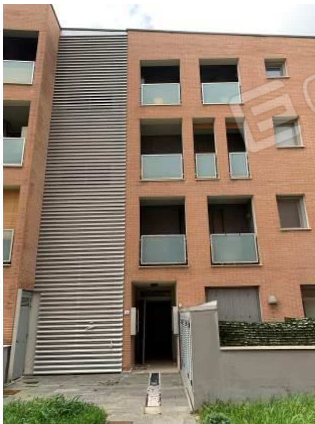
Foto 6: Esterni – Fabbricato B
