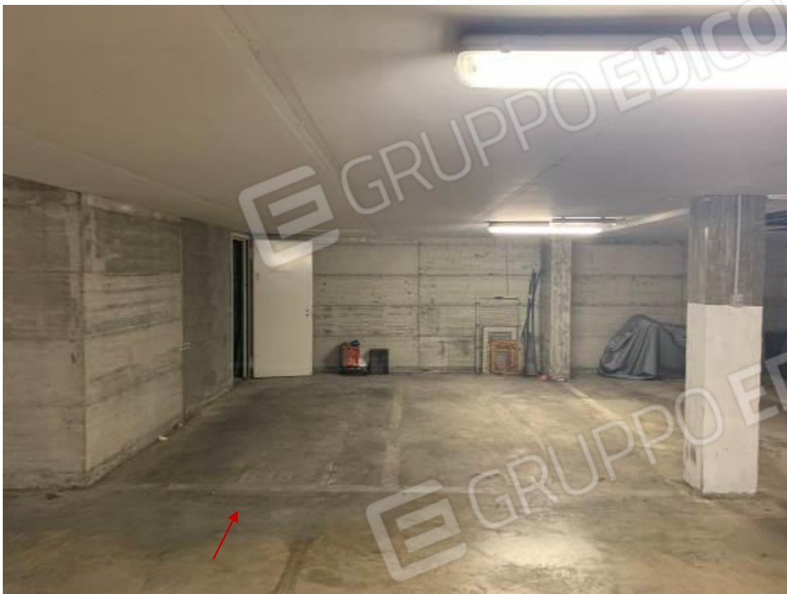
Foto 34: Parcheggio coperto, subalternato 125
