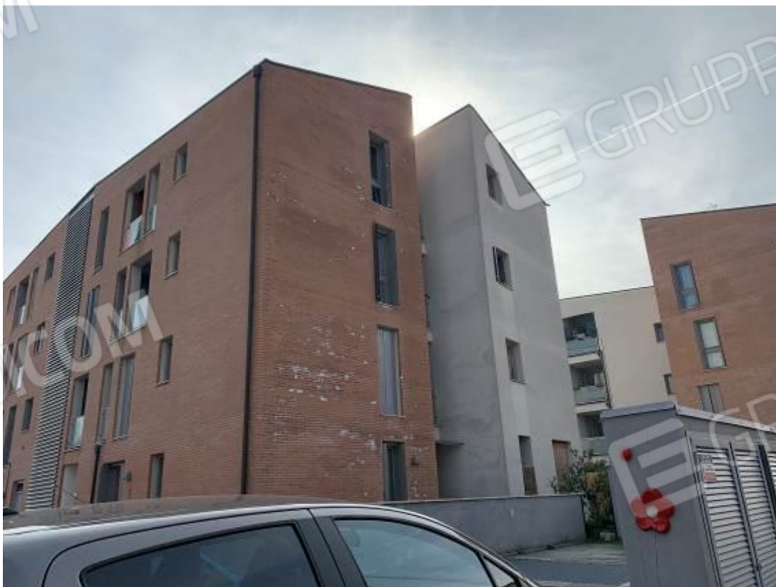
Foto 4: Esterni – Fabbricato B
