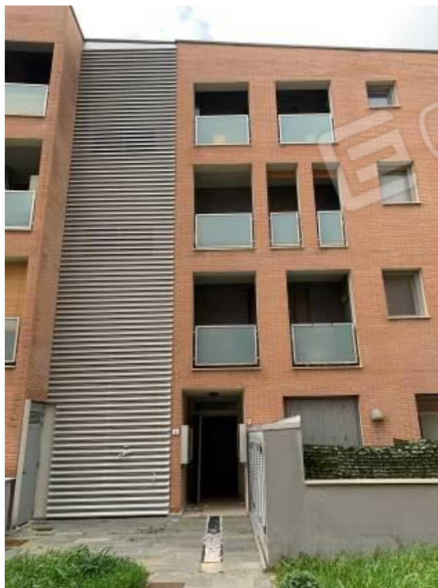
Foto 6: Esterni – Fabbricato B
