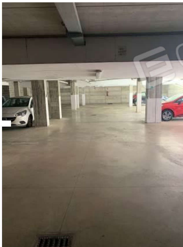
Foto 33: Passaggio carrabile comune – Fabbricato B
