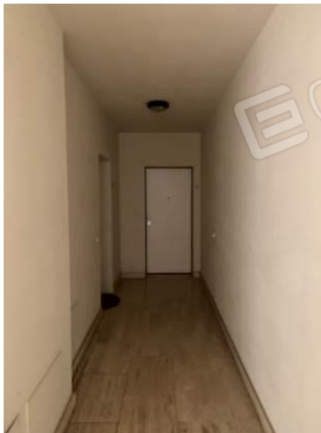
Foto 14: Parti comuni – Fabbricato B
