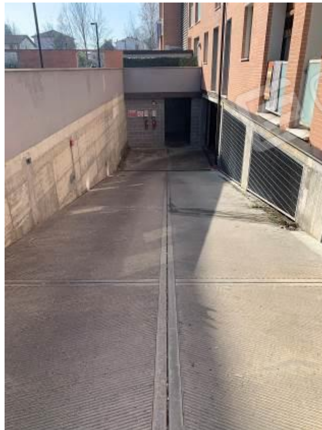
Foto 31: Accesso ai garage – Fabbricato B
