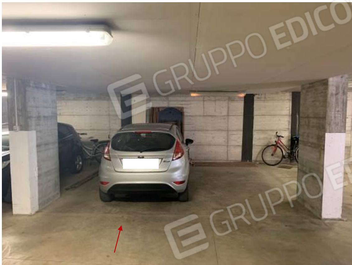
Foto 34: Parcheggio coperto, subalterno 117
