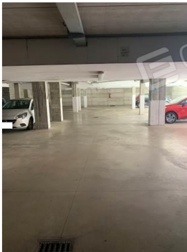
Foto 33: Passaggio carrabile comune – Fabbricato B
