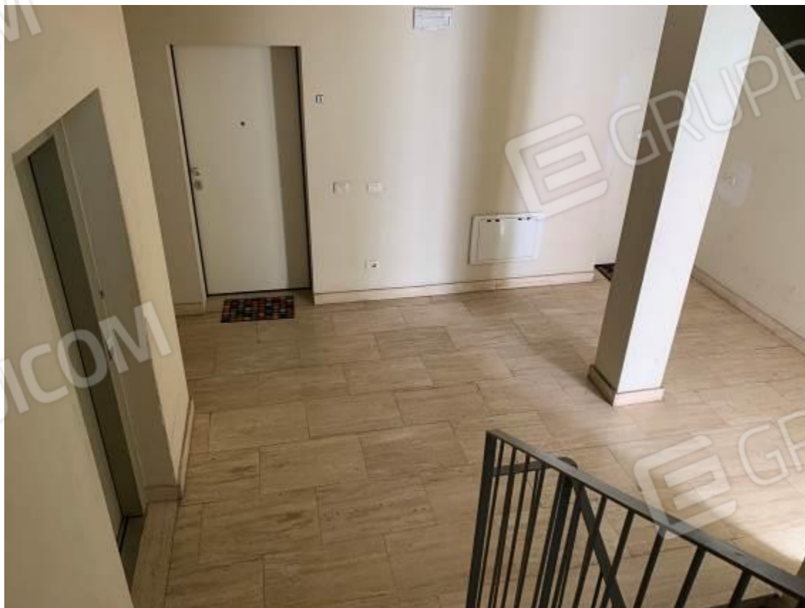
Foto 16: Parti comuni – Fabbricato B
