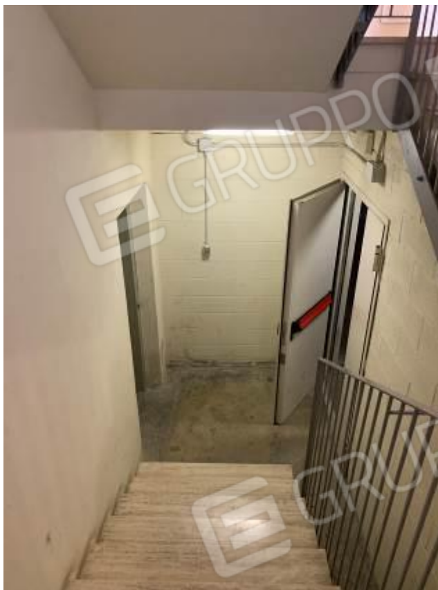
Foto 17: Parti comuni – Fabbricato B
