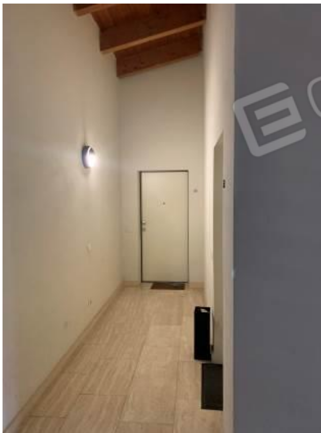
Foto 18: Parti comuni – Fabbricato B
