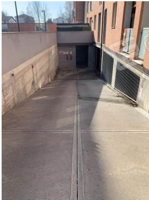
Foto 31: Accesso ai garage – Fabbricato B
