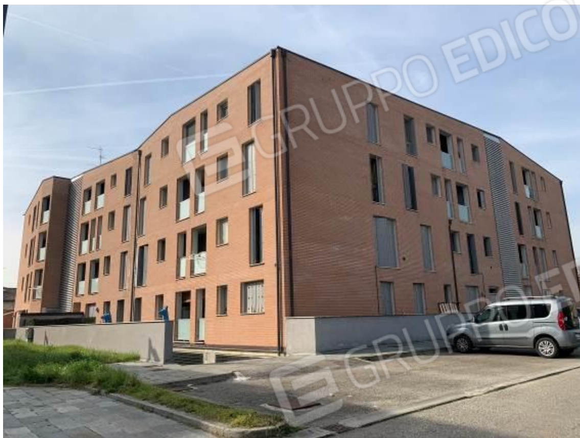
Foto 3: Esterni – Fabbricato B
