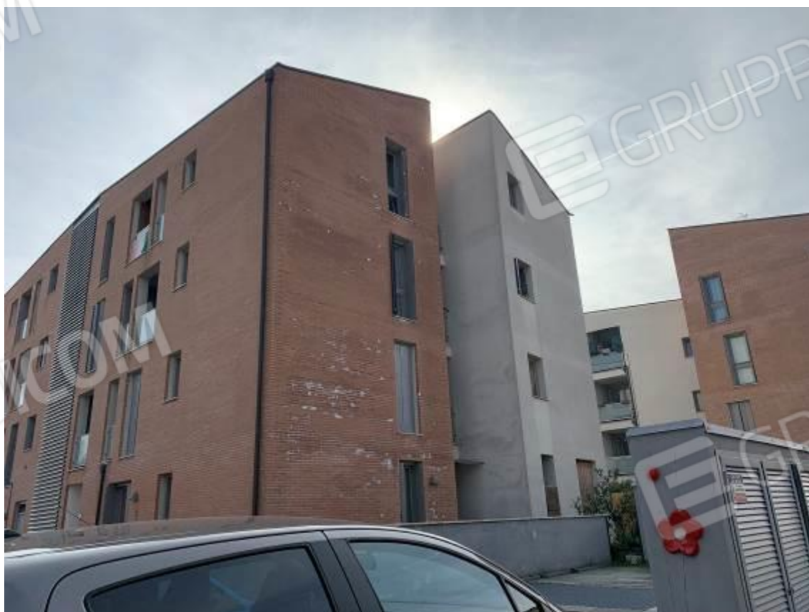
Foto 4: Esterni – Fabbricato B
