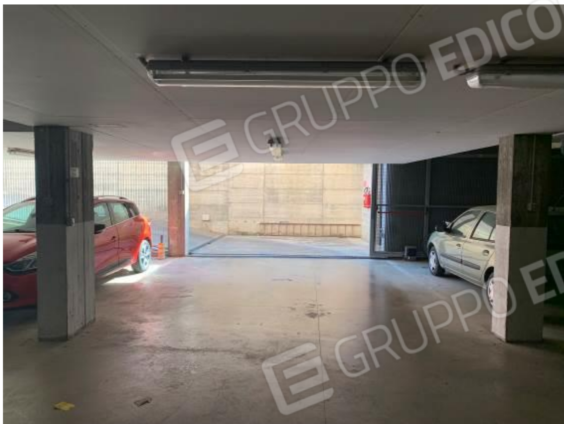
Foto 32: Passaggio carrabile comune – Fabbricato B
