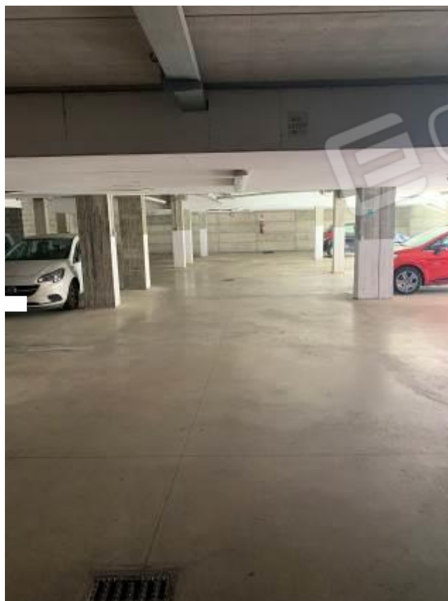
Foto 33: Passaggio carrabile comune – Fabbricato B
