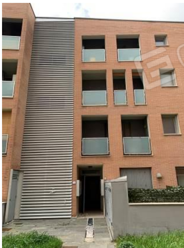
Foto 6: Esterni – Fabbricato B
