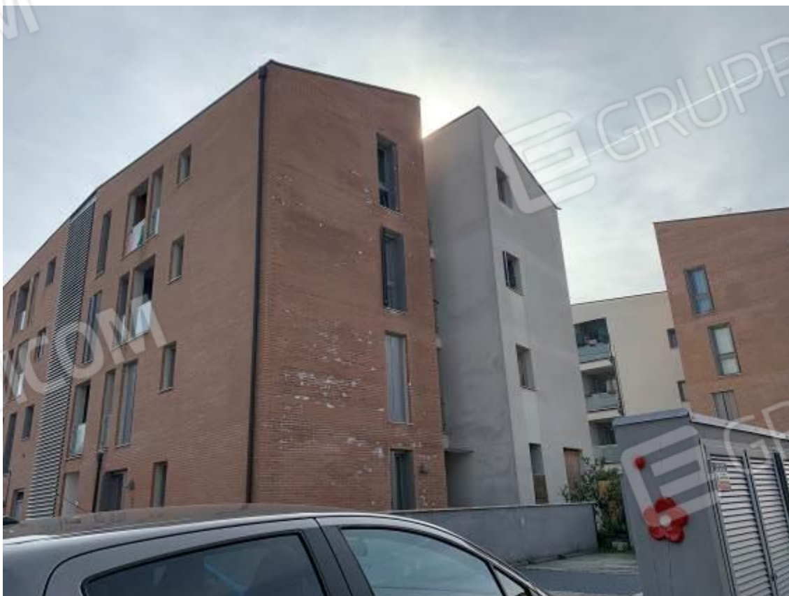
Foto 4: Esterni – Fabbricato B
