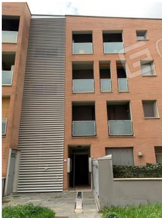
Foto 6: Esterni – Fabbricato B
