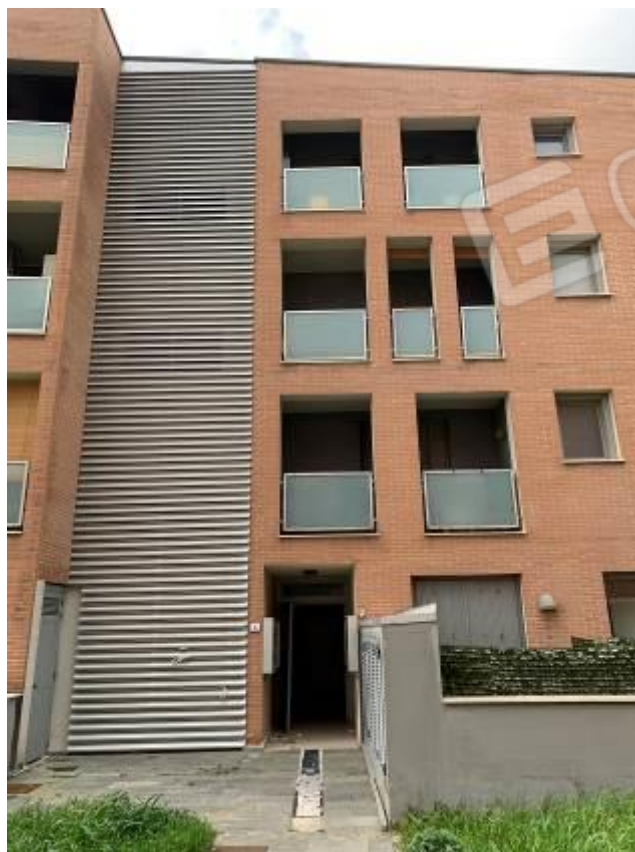
Foto 6: Esterni – Fabbricato B
