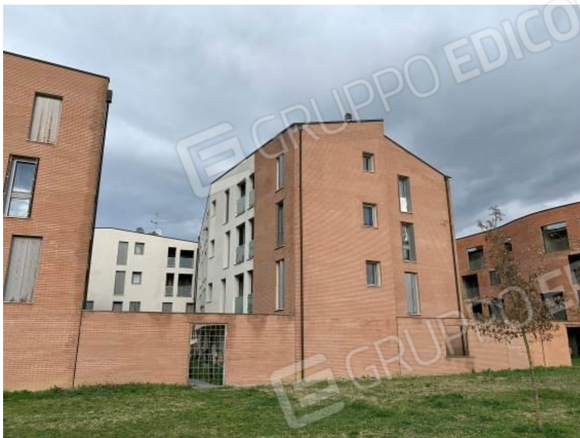
Foto 7: Esterni – Fabbricato B
