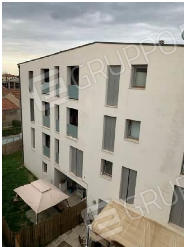
Foto 9: Esterni – Fabbricato B
