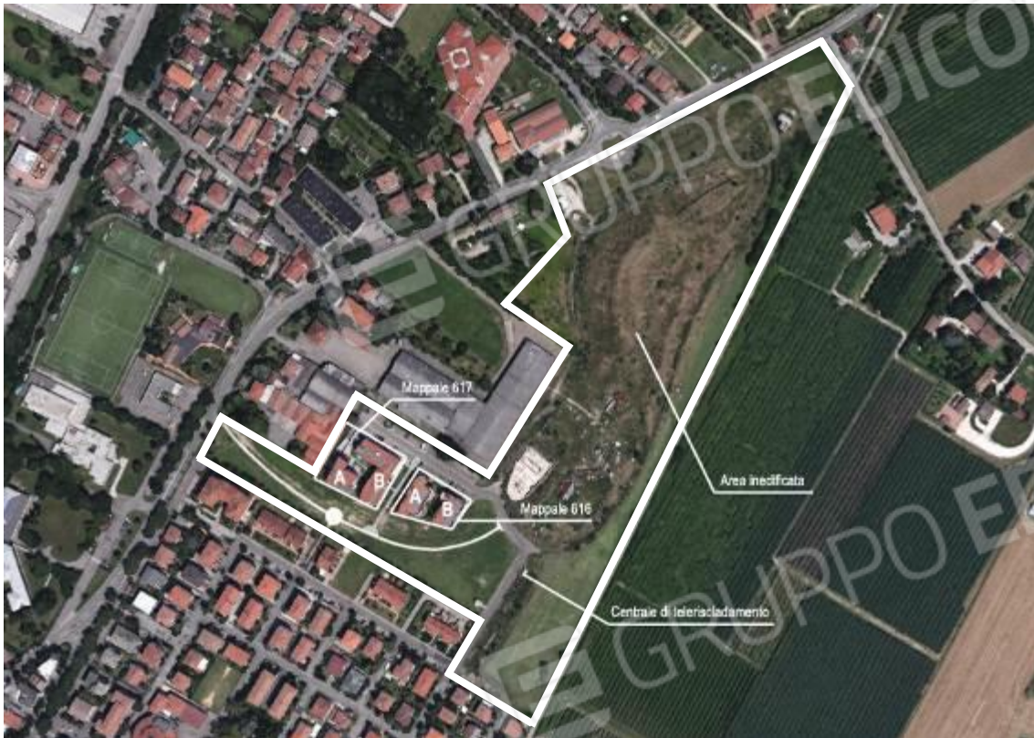
Foto 1: Vista aerea – Perimetro area di interesse
