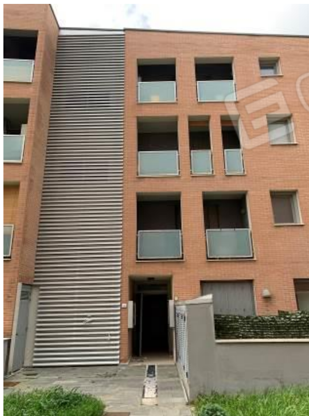
Foto 6: Esterni – Fabbricato B
