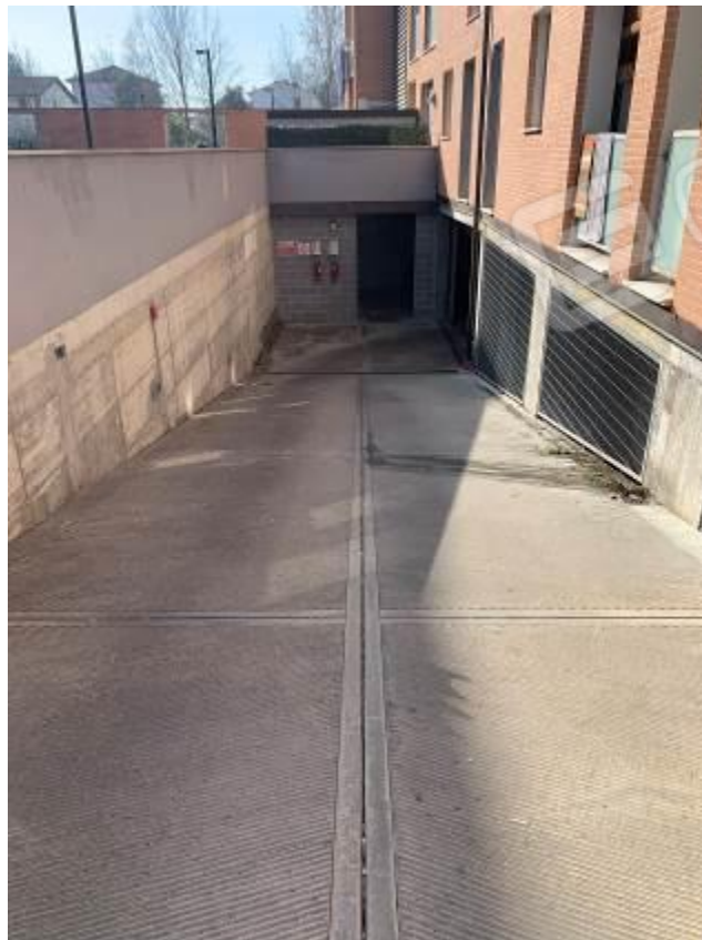
Foto 31: Accesso ai garage – Fabbricato B
