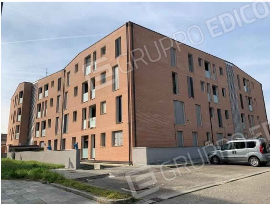
Foto 3: Esterni – Fabbricato B
