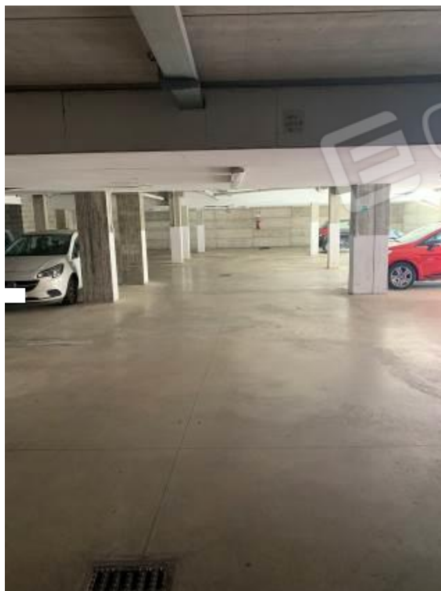
Foto 33: Passaggio carrabile comune – Fabbricato B
