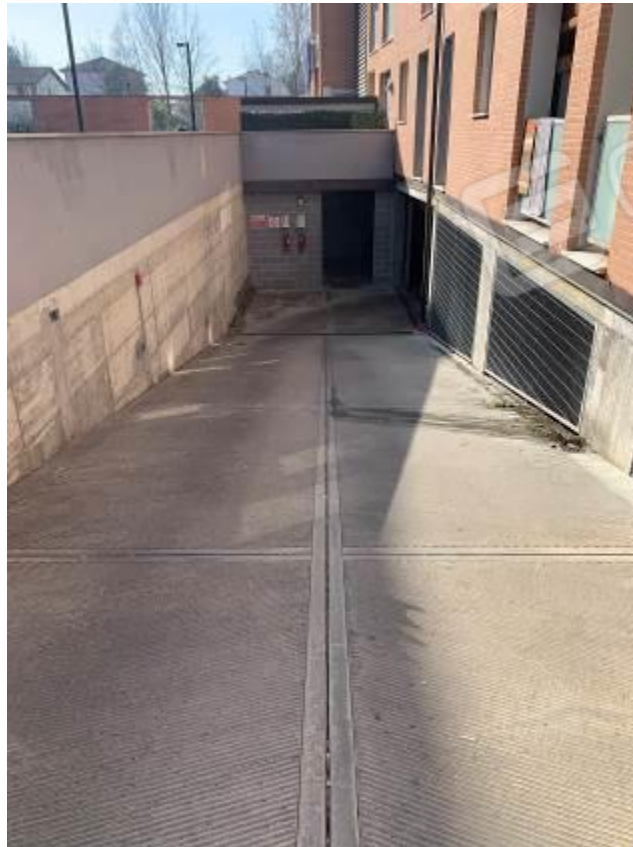
Foto 31: Accesso ai garage – Fabbricato B
