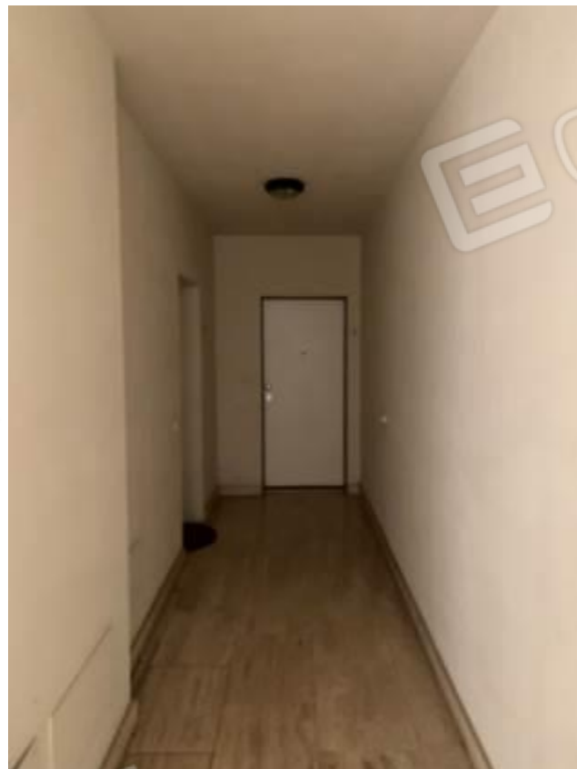
Foto 14: Parti comuni – Fabbricato B
