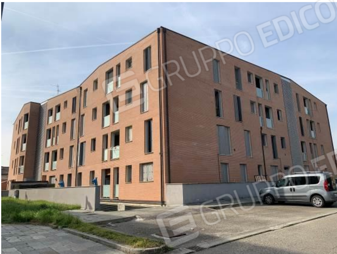
Foto 3: Esterni – Fabbricato B
