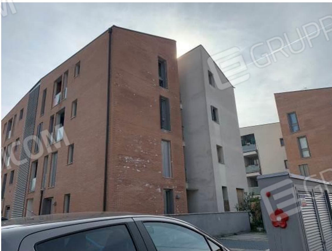
Foto 4: Esterni – Fabbricato B
