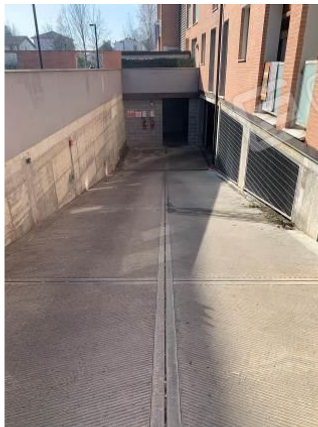
Foto 31: Accesso ai garage – Fabbricato B
