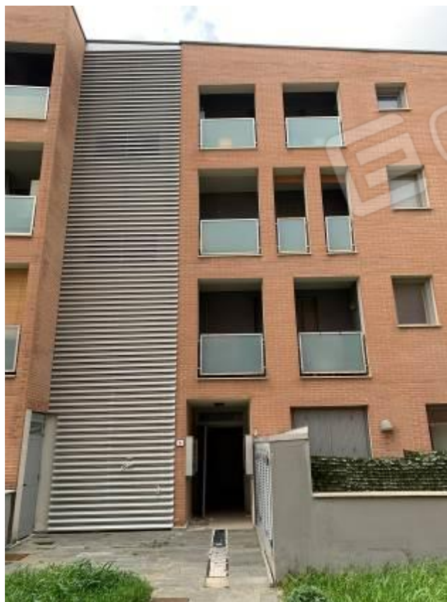
Foto 6: Esterni – Fabbricato B
