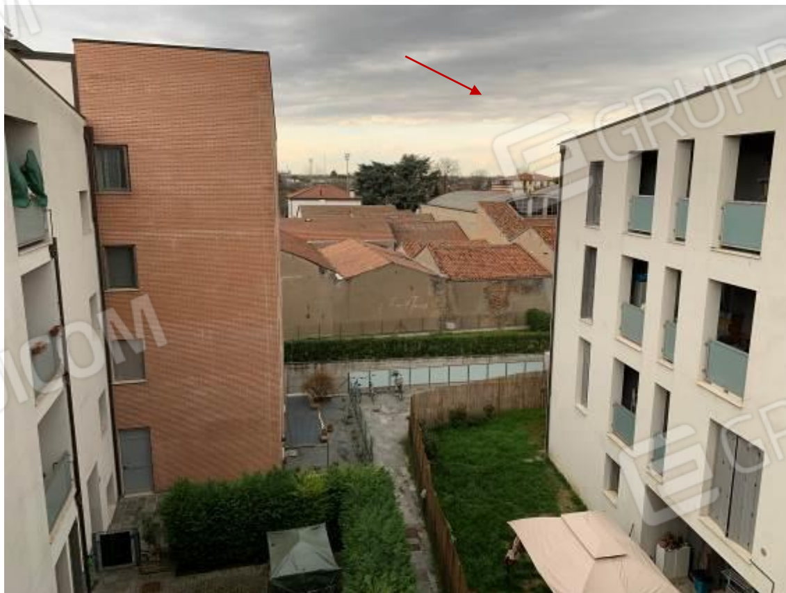
Foto 10: Esterni – Fabbricato B
