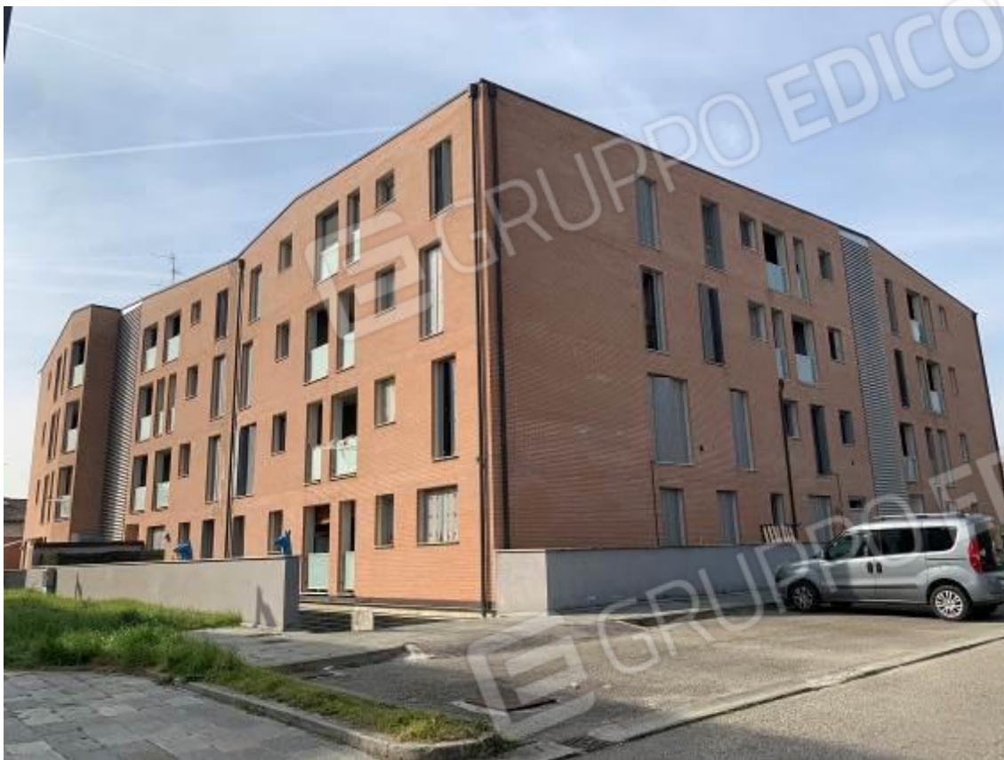
Foto 3: Esterni – Fabbricato B
