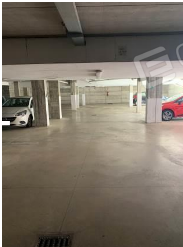
Foto 33: Passaggio carrabile comune – Fabbricato B
