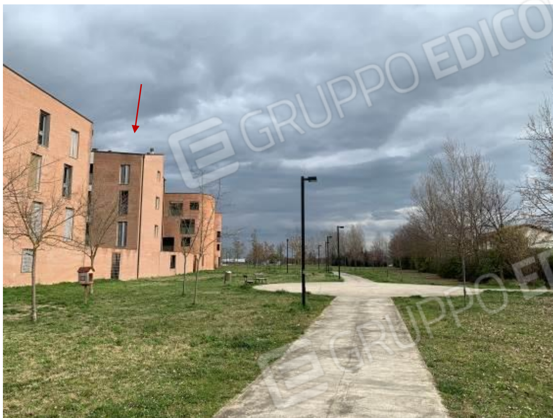
Foto 11: Esterni – area circostante
