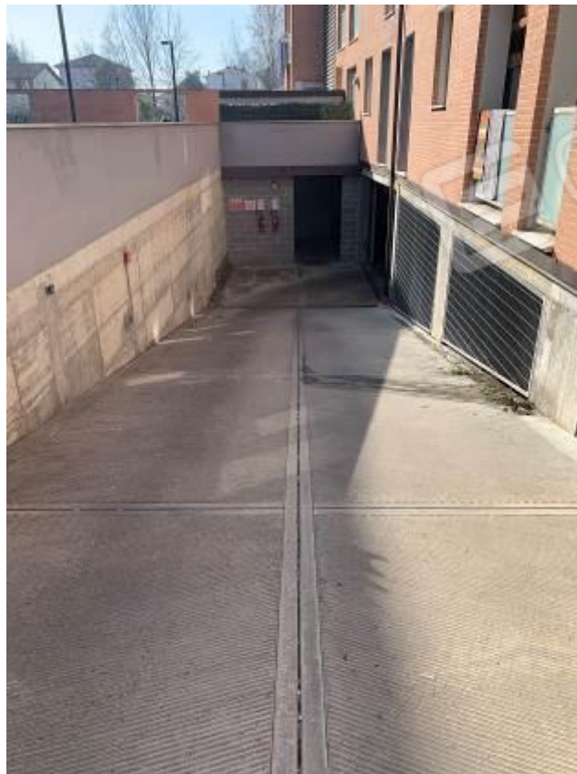
Foto 31: Accesso ai garage – Fabbricato B
