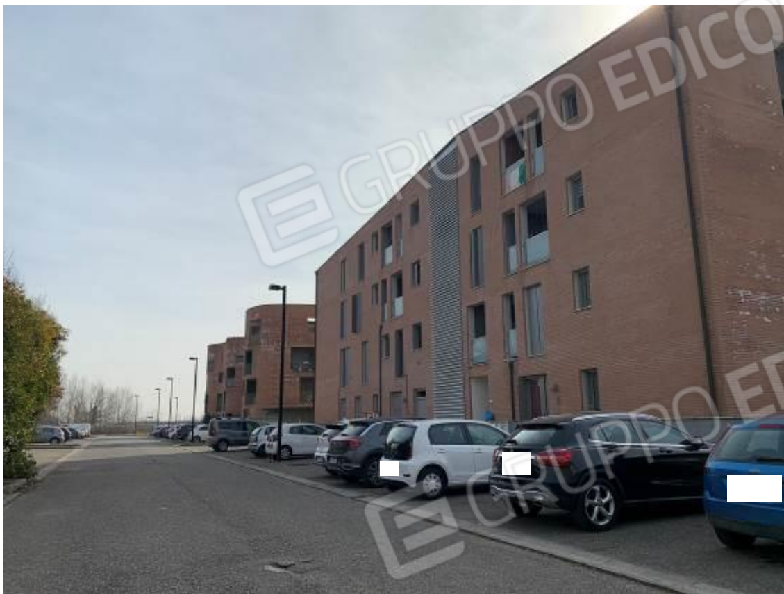
Foto 5: Esterni – Fabbricato B
