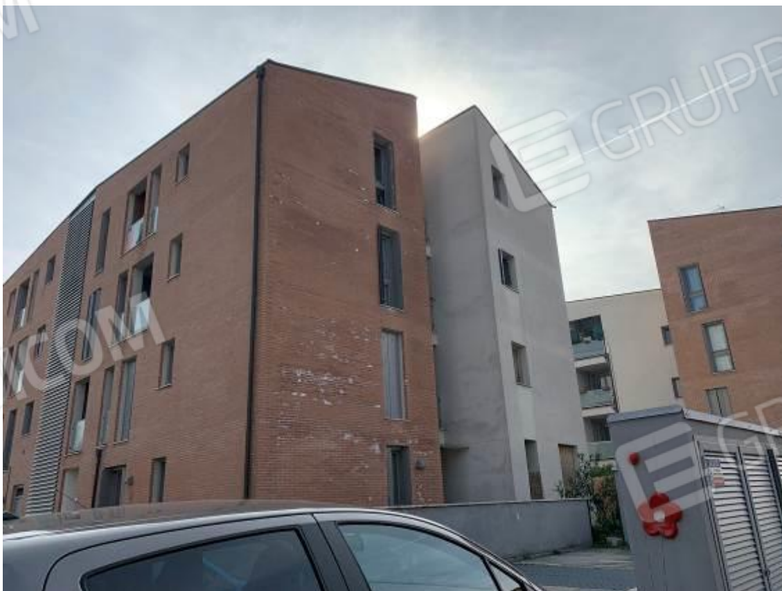
Foto 4: Esterni – Fabbricato B
