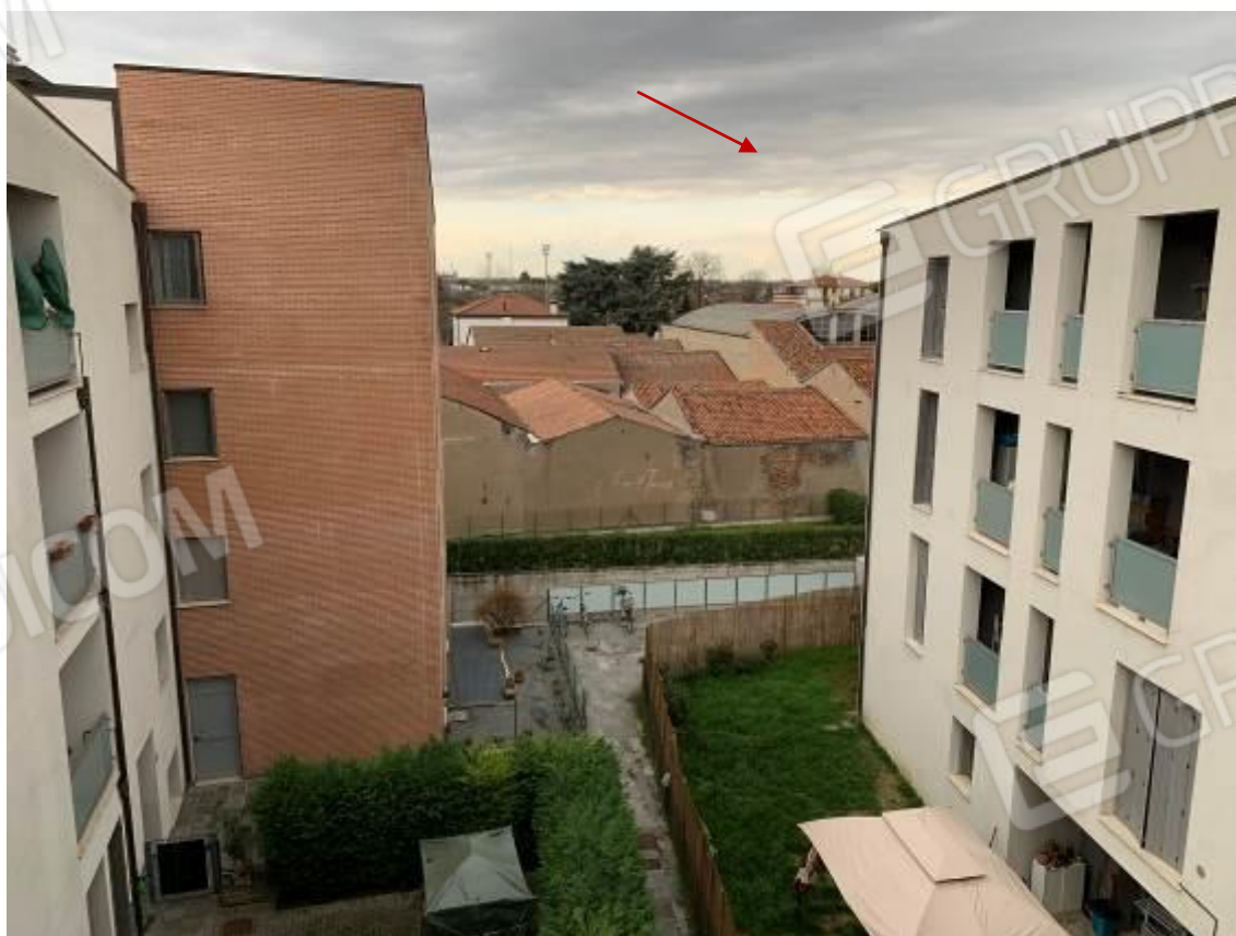
Foto 10: Esterni – Fabbricato B
