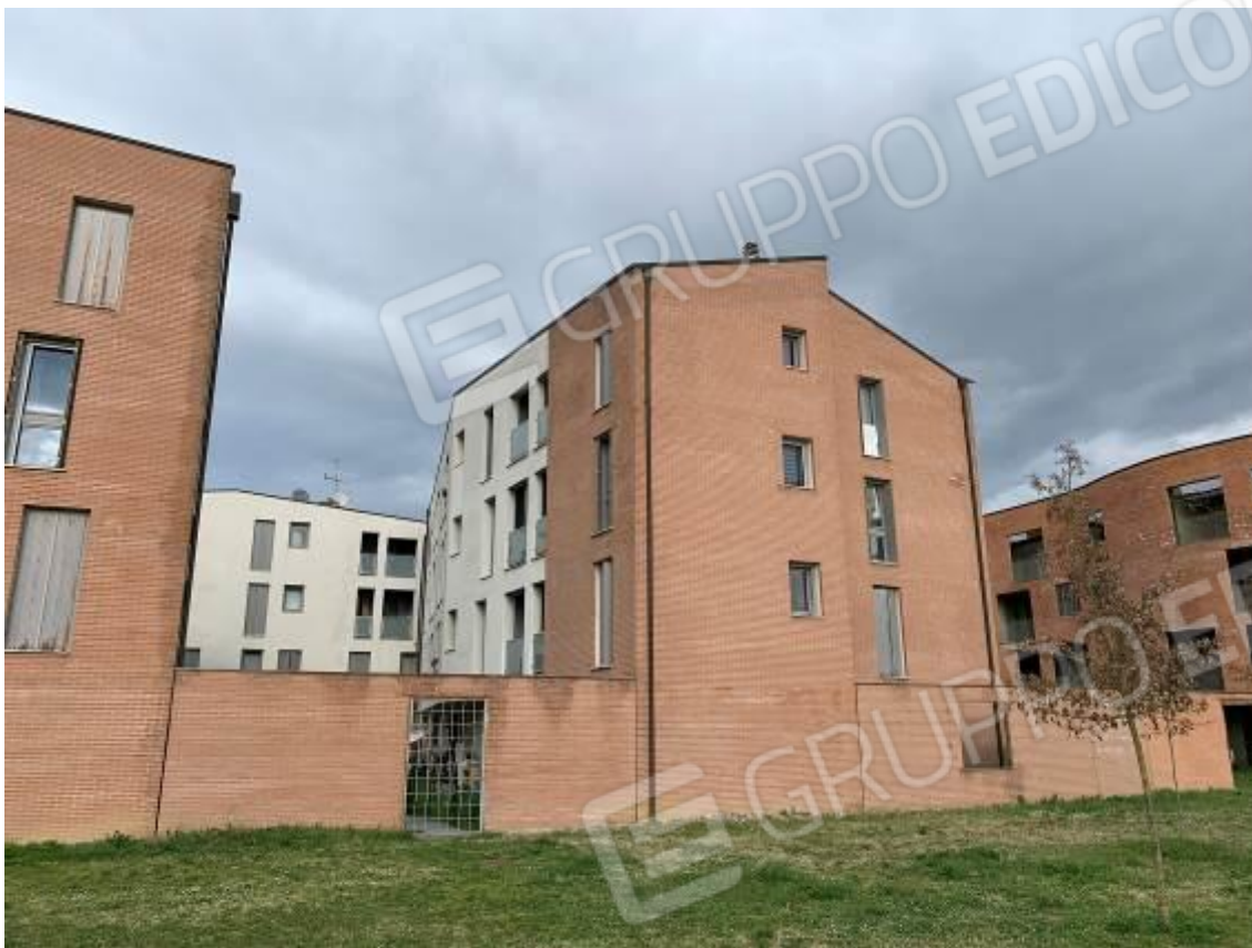
Foto 7: Esterni – Fabbricato B
