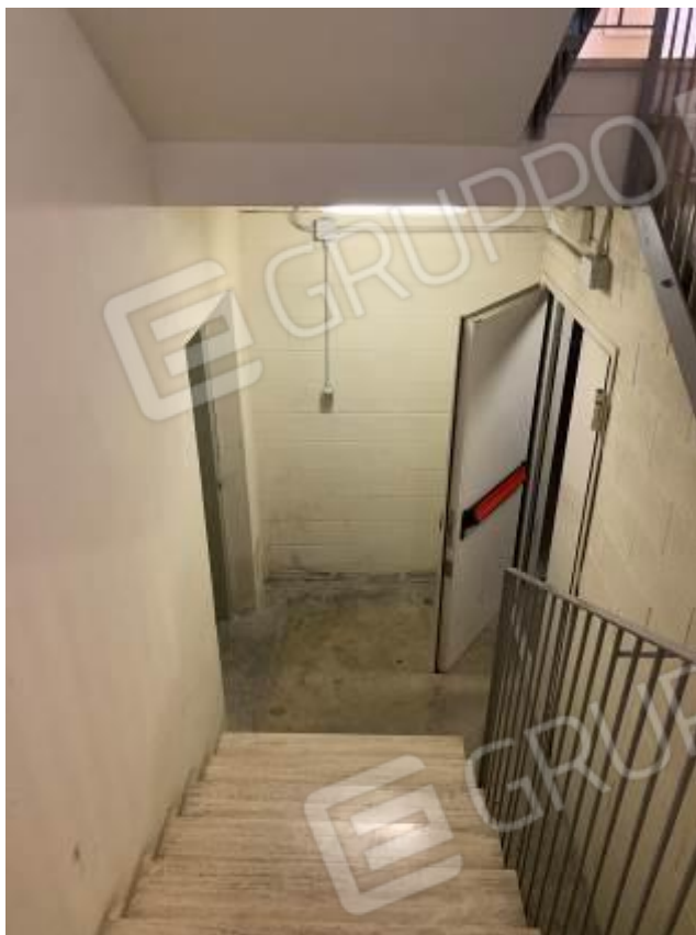
Foto 17: Parti comuni – Fabbricato B
