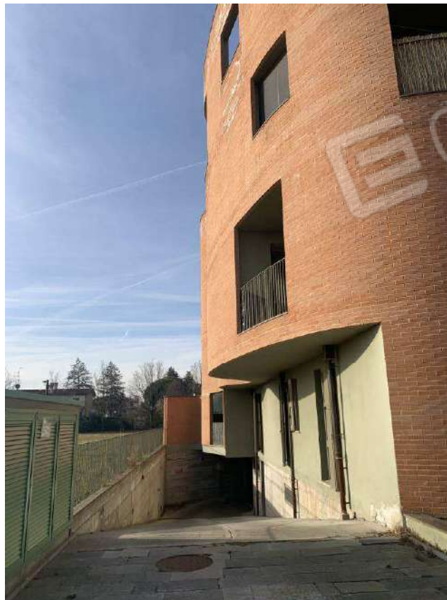
Foto 29: Accesso ai garage – Fabbricato B
