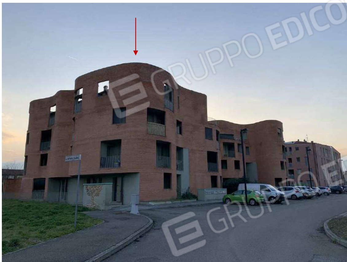
Foto 5: Esterni – Fabbricato B
