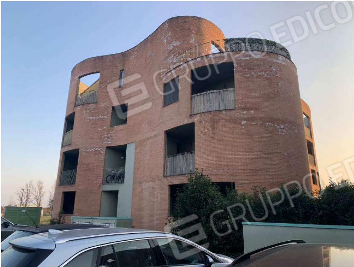
Foto 3: Esterni – Fabbricato B
