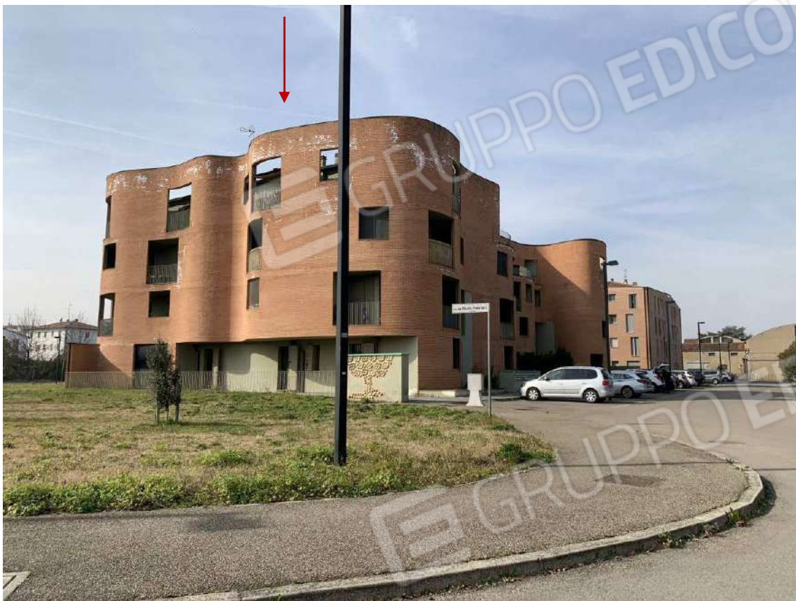
Foto 7: Esterni – Fabbricato B
