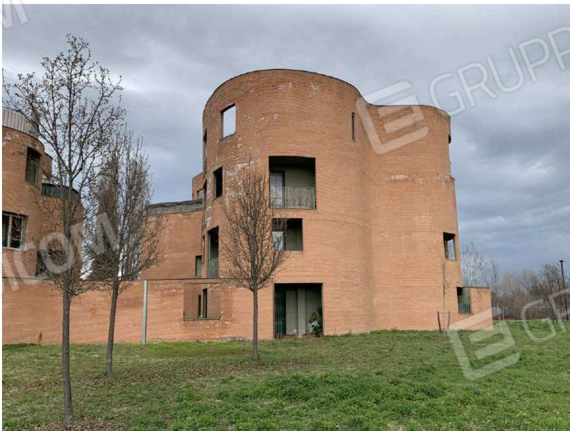
Foto 6: Esterni – Fabbricato B
