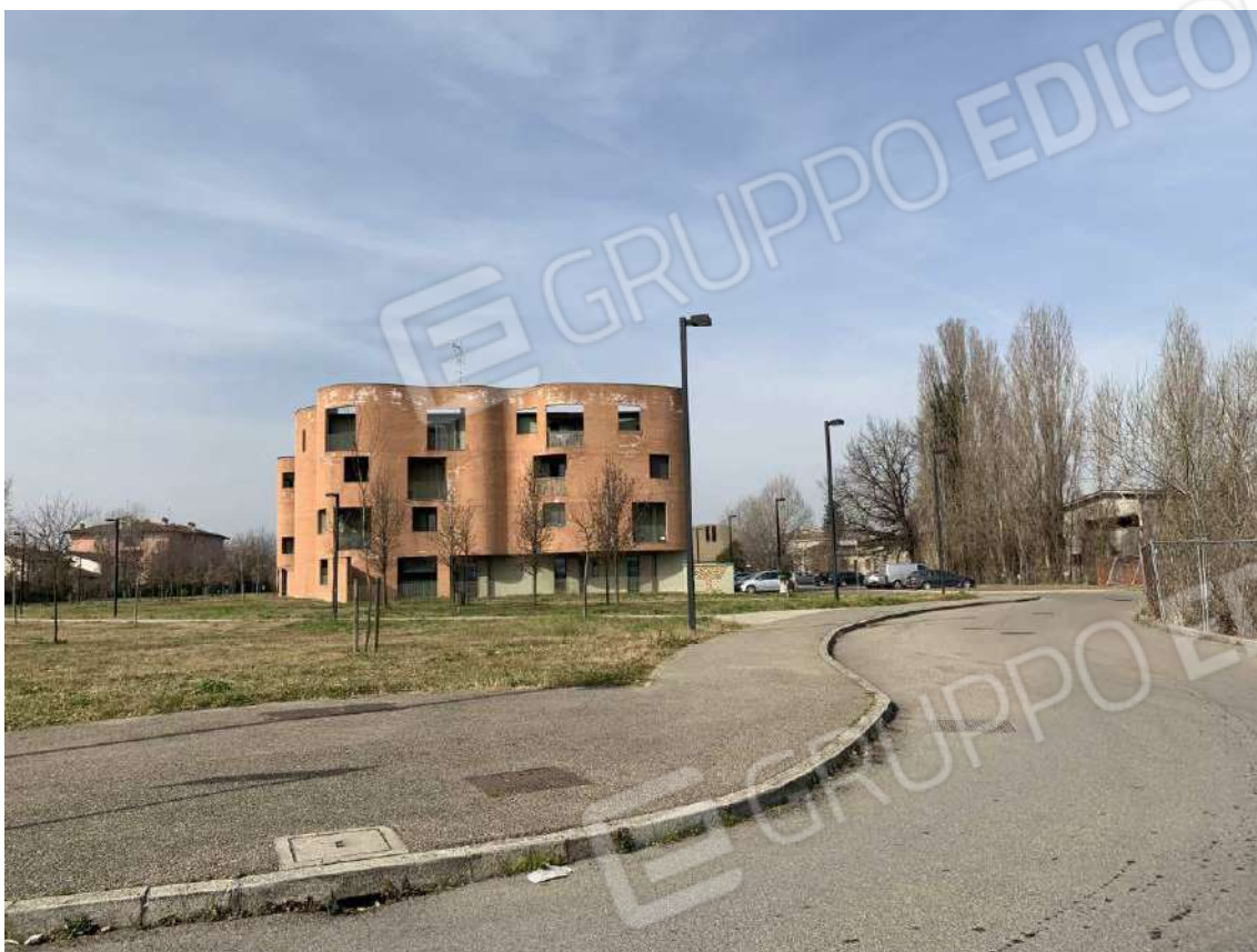
Foto 9: Esterni – Fabbricato B
