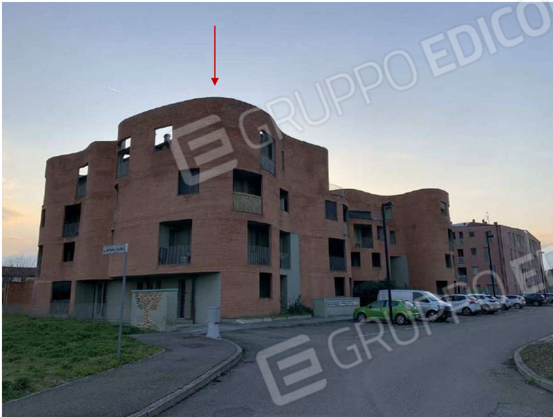
Foto 5: Esterni – Fabbricato B
