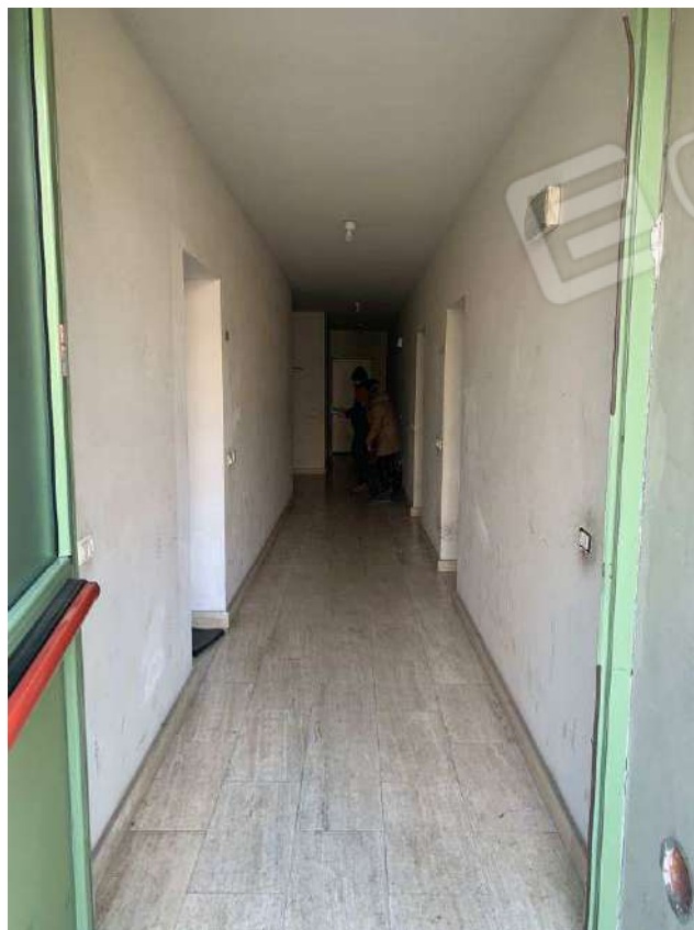
Foto 14: Parti comuni – Fabbricato B
