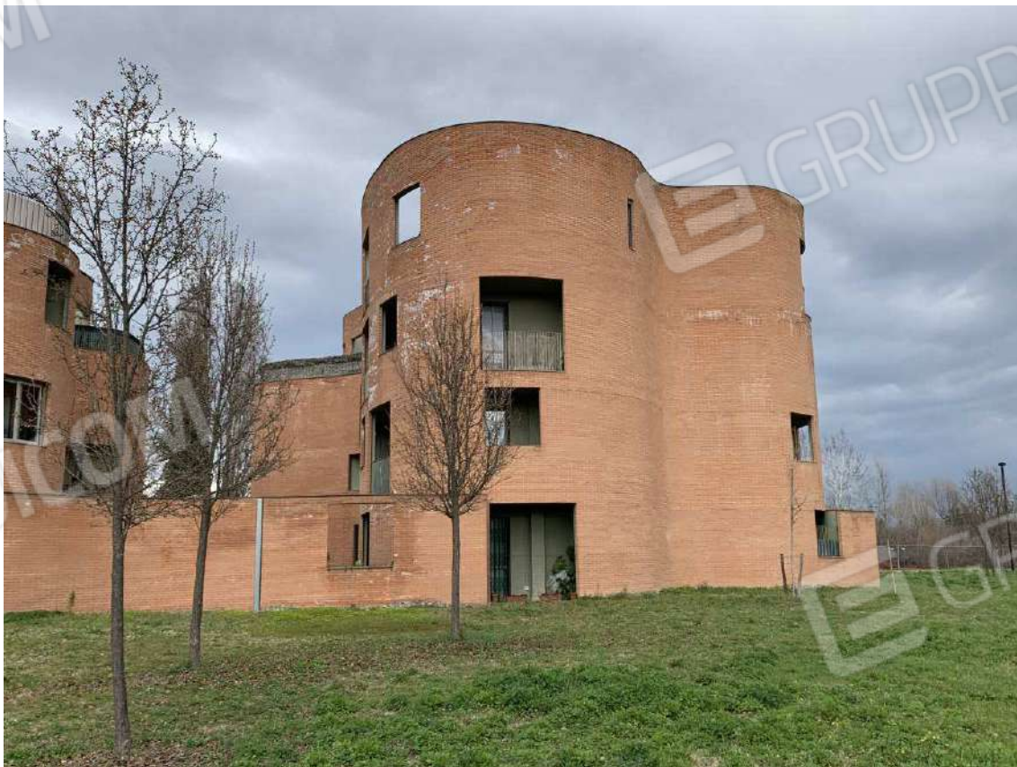
Foto 6: Esterni – Fabbricato B
