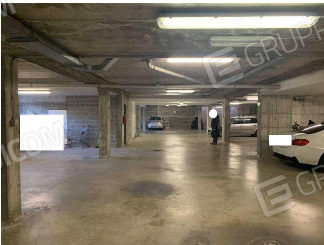
Foto 33: Passaggio carrabile comune – Fabbricato B
