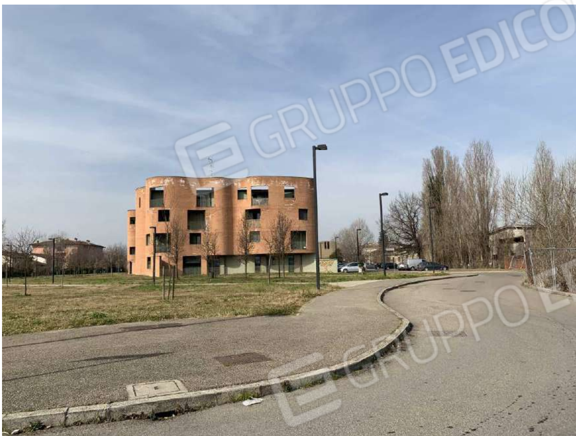
Foto 9: Esterni – Fabbricato B
