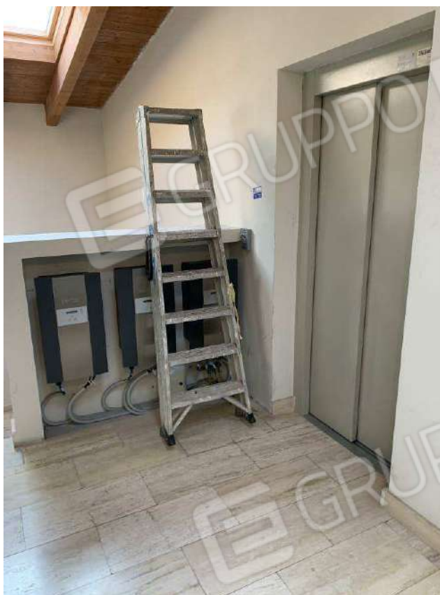
Foto 17: Parti comuni – Fabbricato B
