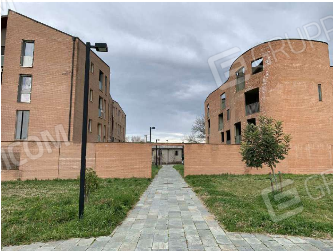
Foto 12: Esterni – area circostante
