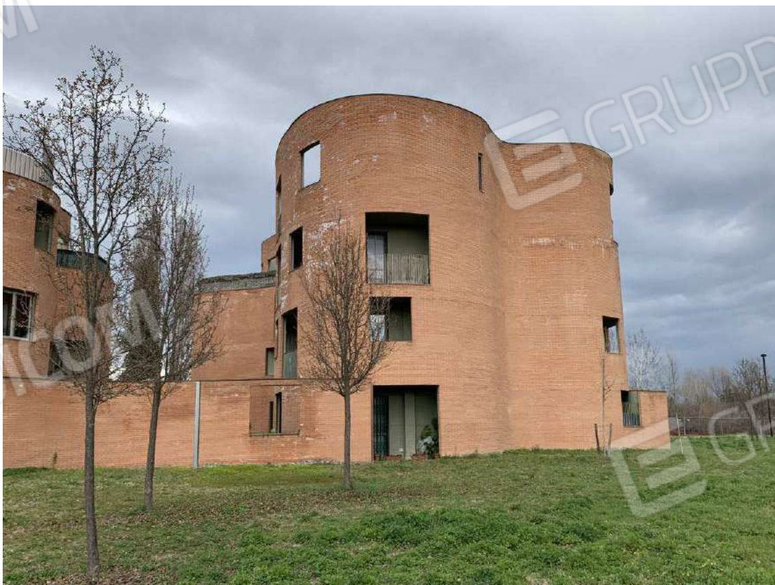
Foto 6: Esterni – Fabbricato B
