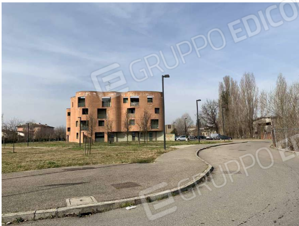
Foto 9: Esterni – Fabbricato B
