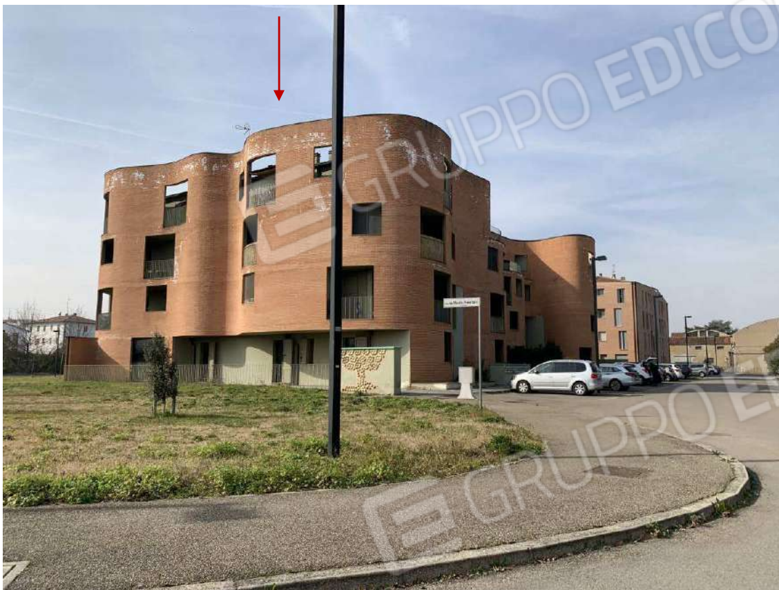
Foto 7: Esterni – Fabbricato B
