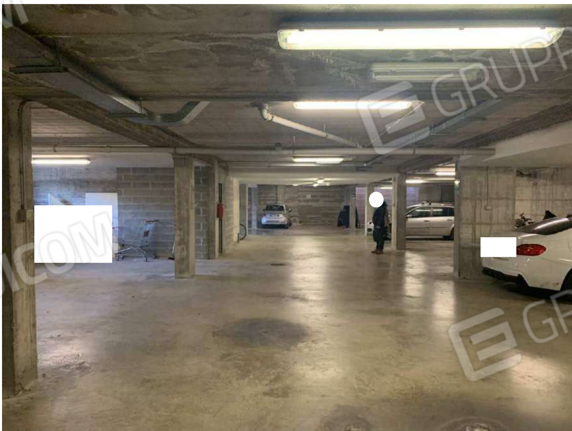
Foto 33: Passaggio carrabile comune – Fabbricato B
