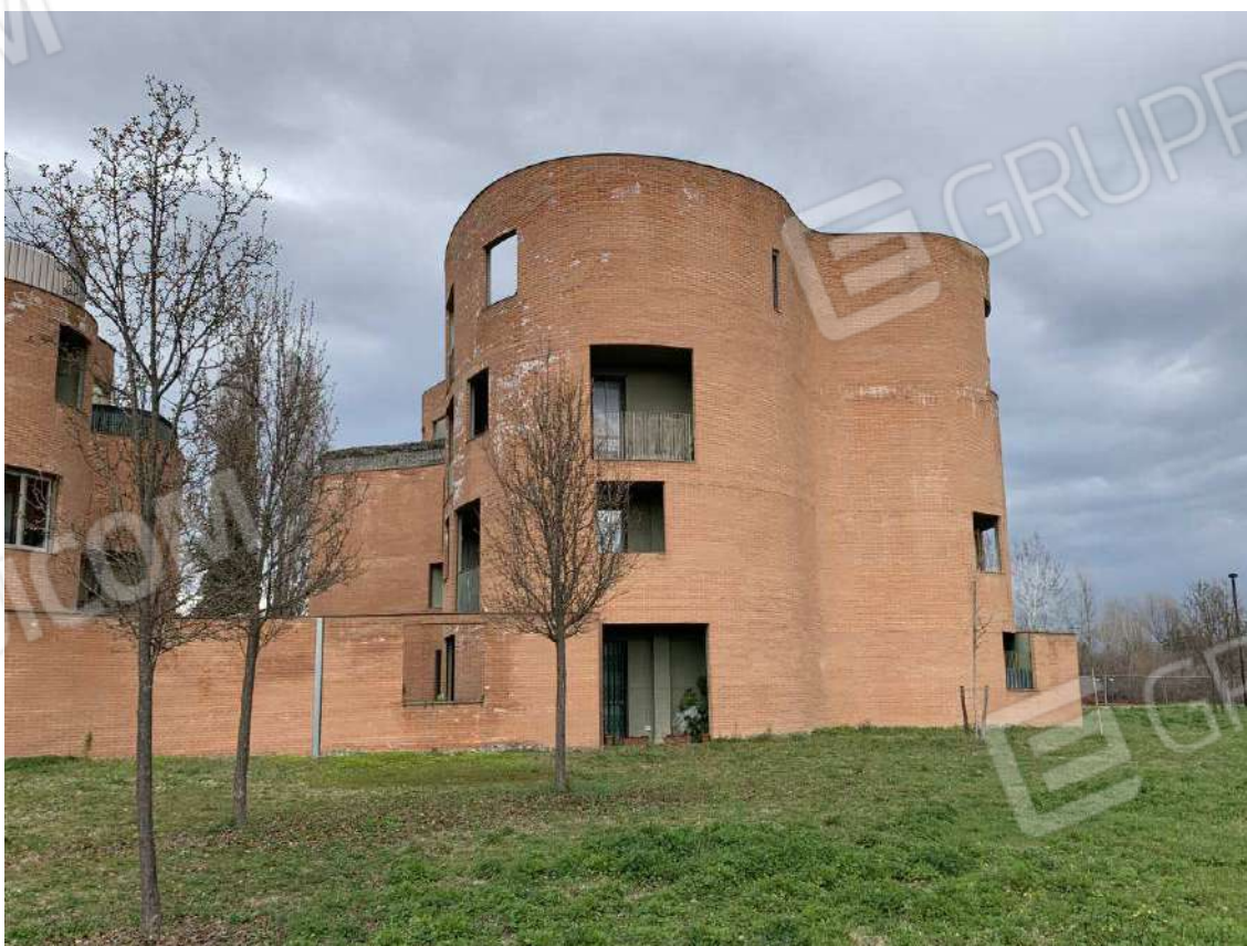
Foto 6: Esterni – Fabbricato B
