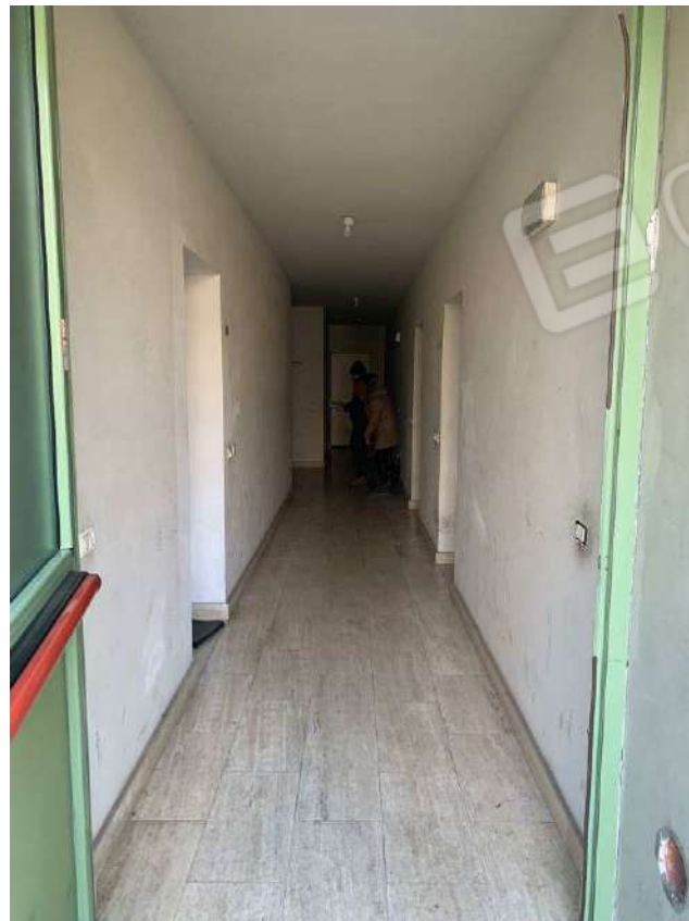
Foto 14: Parti comuni – Fabbricato B
