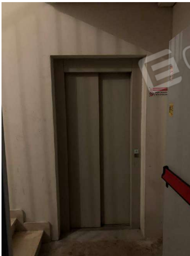
Foto 18: Parti comuni – Fabbricato B
