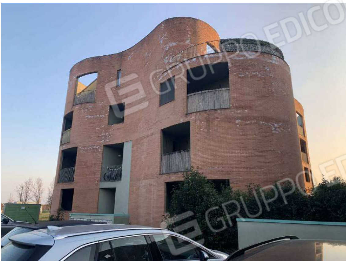
Foto 3: Esterni – Fabbricato B
