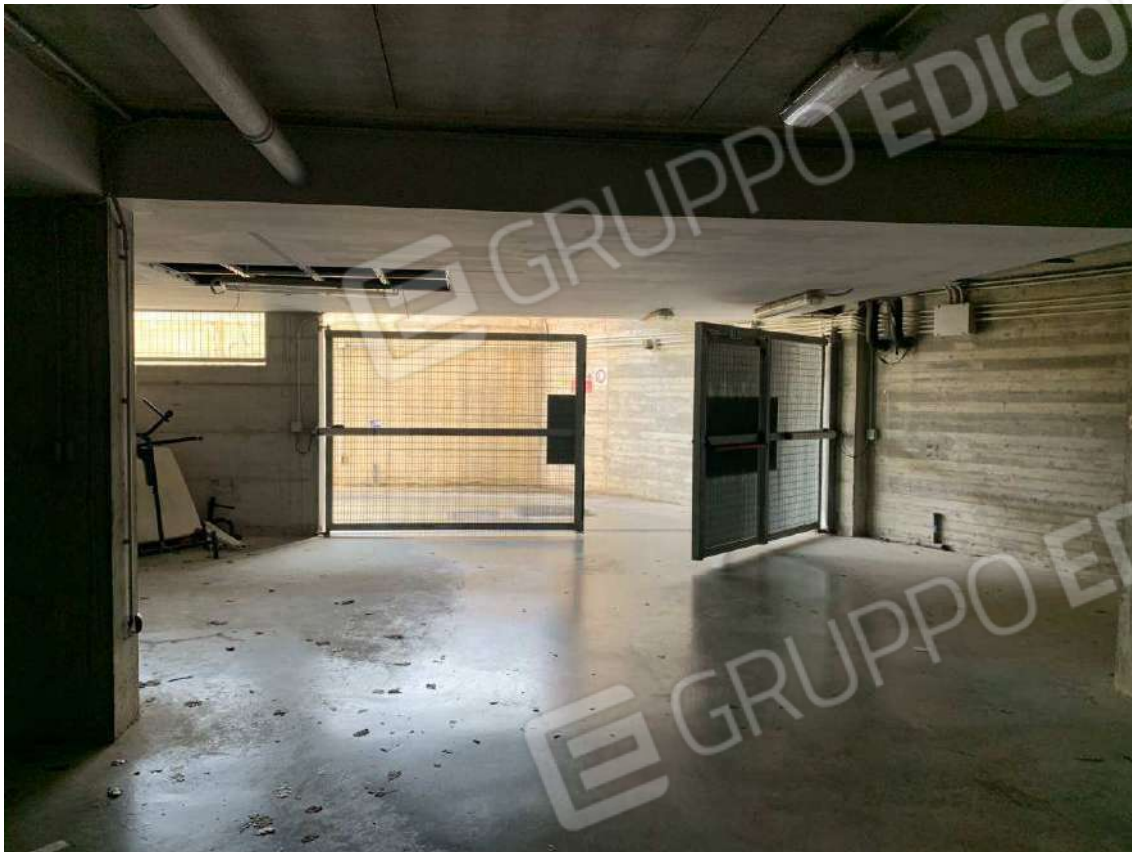
Foto 32: Passaggio carrabile comune – Fabbricato B
