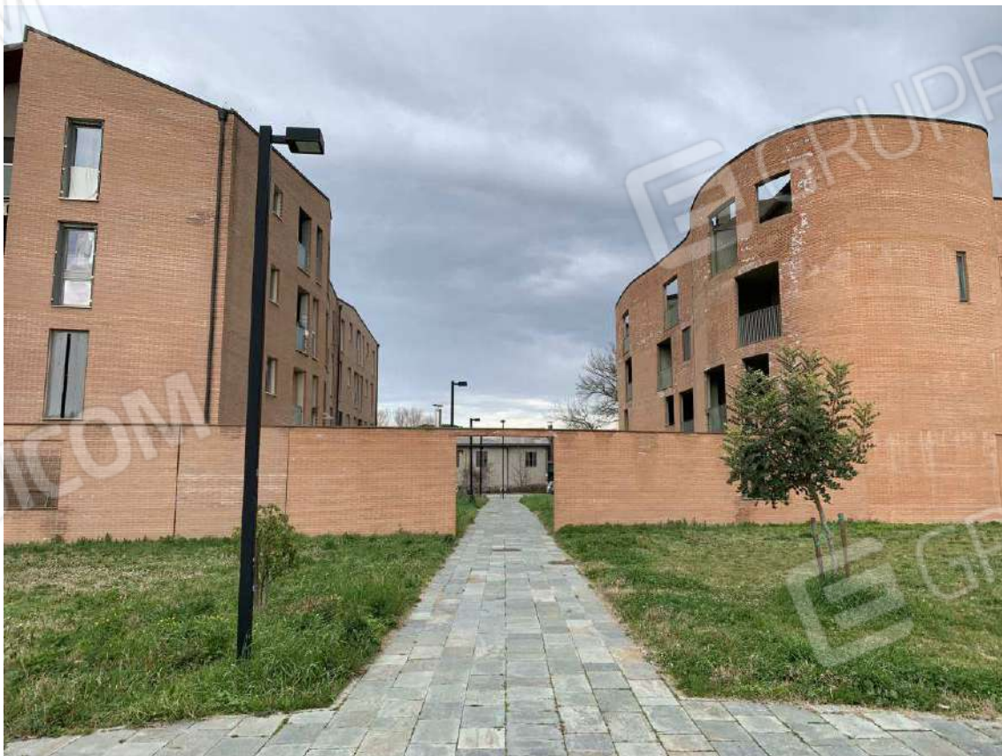
Foto 12: Esterni – area circostante
