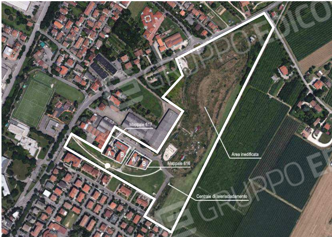
Foto 1: Vista aerea – Perimetro area di interesse
