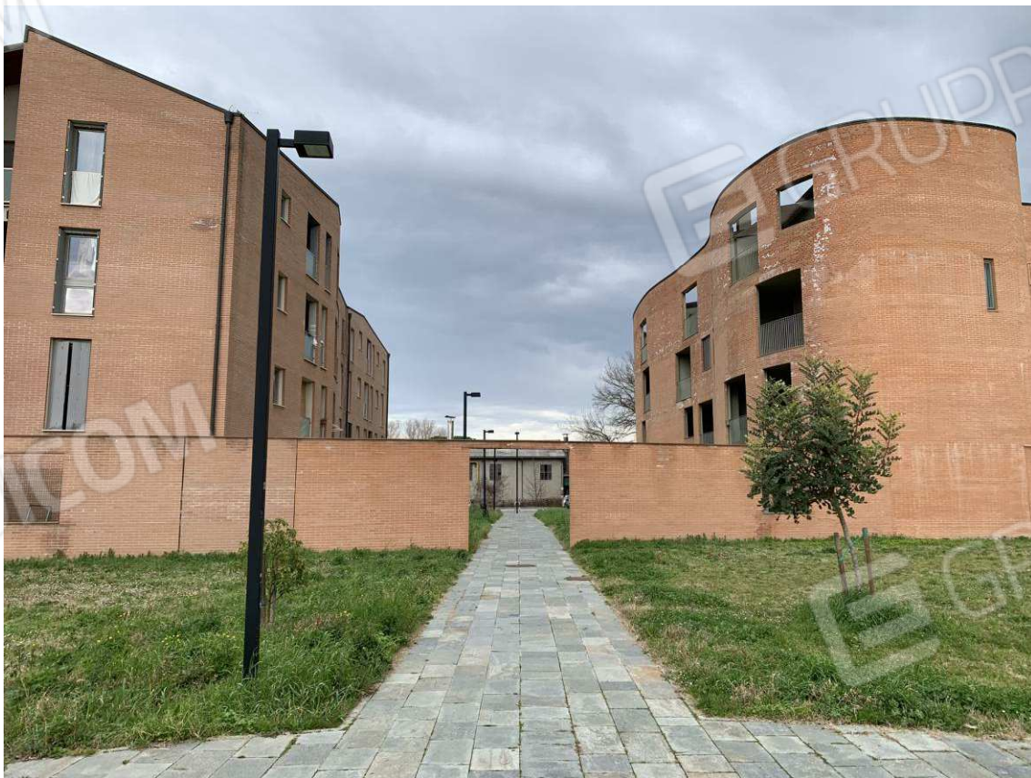
Foto 12: Esterni – area circostante
