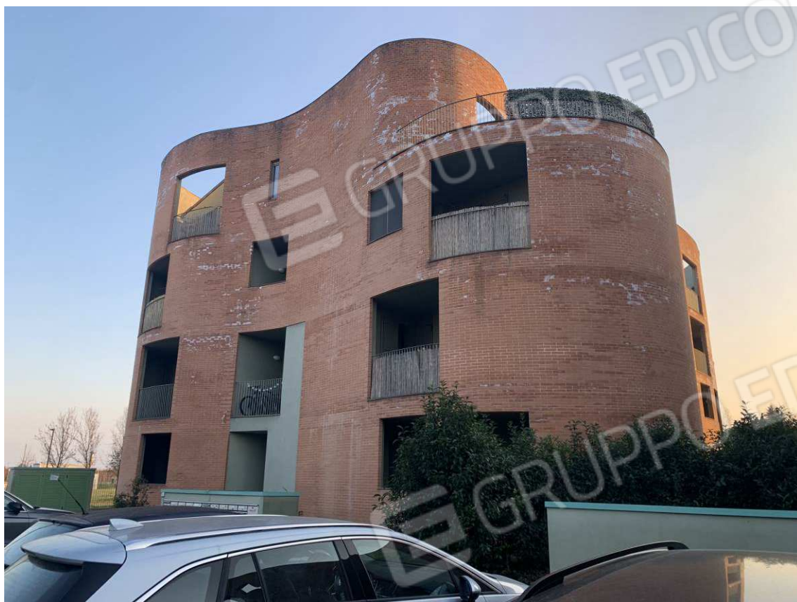
Foto 3: Esterni – Fabbricato B
