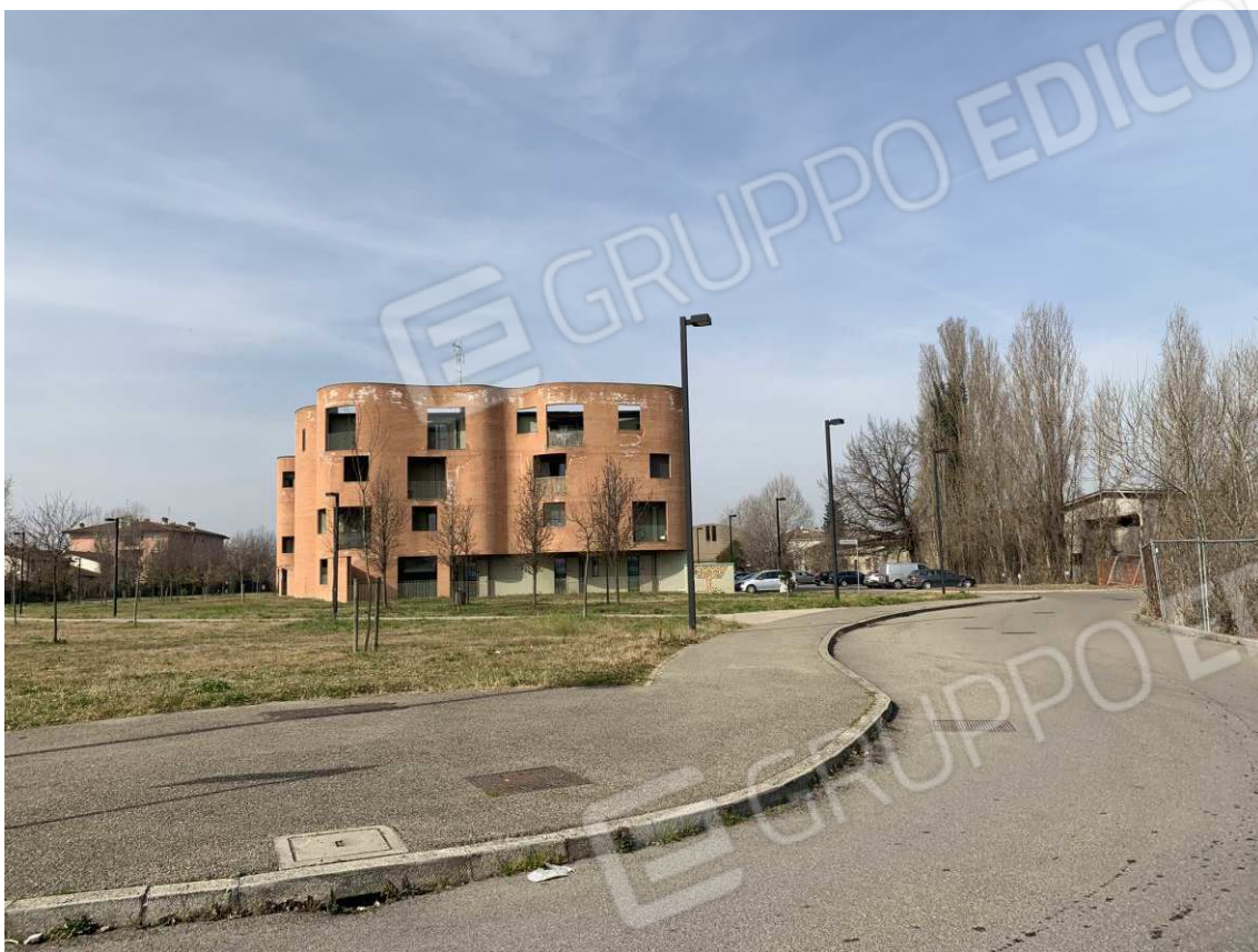
Foto 9: Esterni – Fabbricato B
