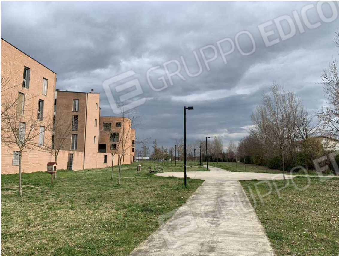
Foto 11: Esterni – area circostante
