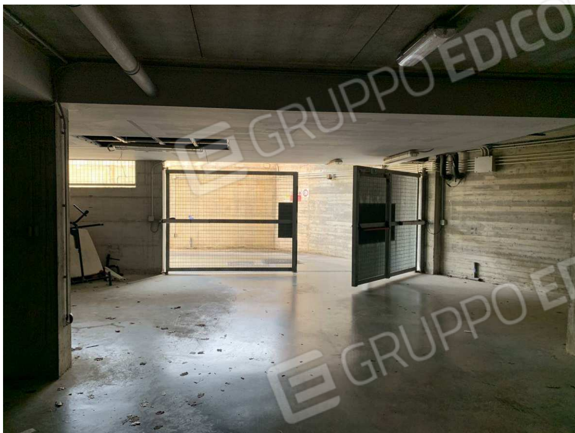
Foto 30: Passaggio carrabile comune – Fabbricato B
