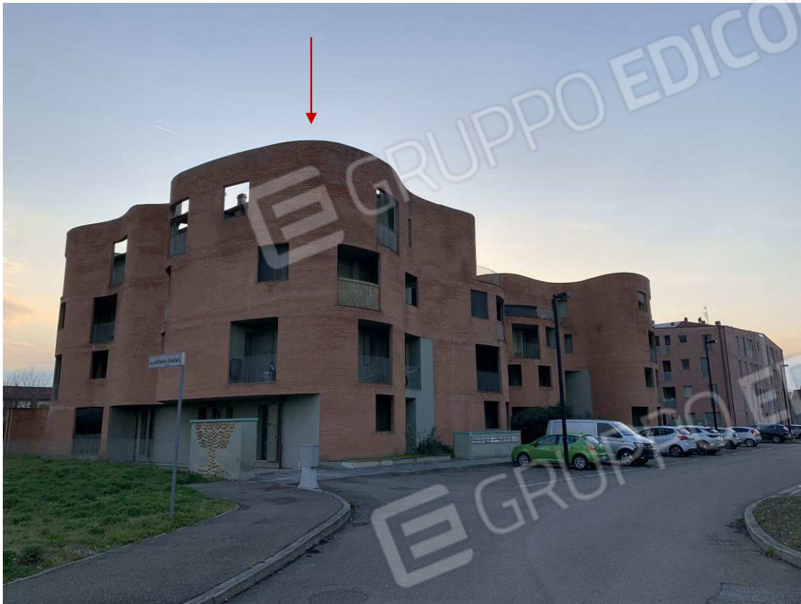
Foto 5: Esterni – Fabbricato B
