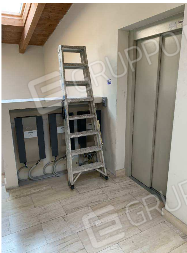
Foto 17: Parti comuni – Fabbricato B
