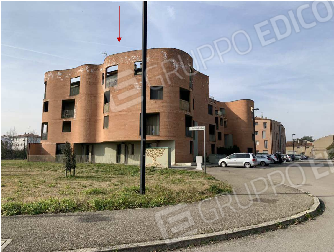
Foto 7: Esterni – Fabbricato B
