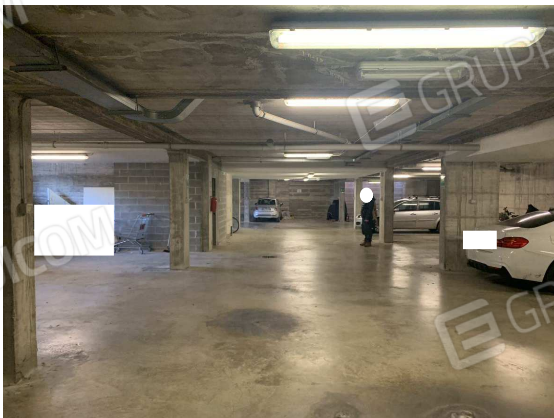
Foto 31: Passaggio carrabile comune – Fabbricato B
