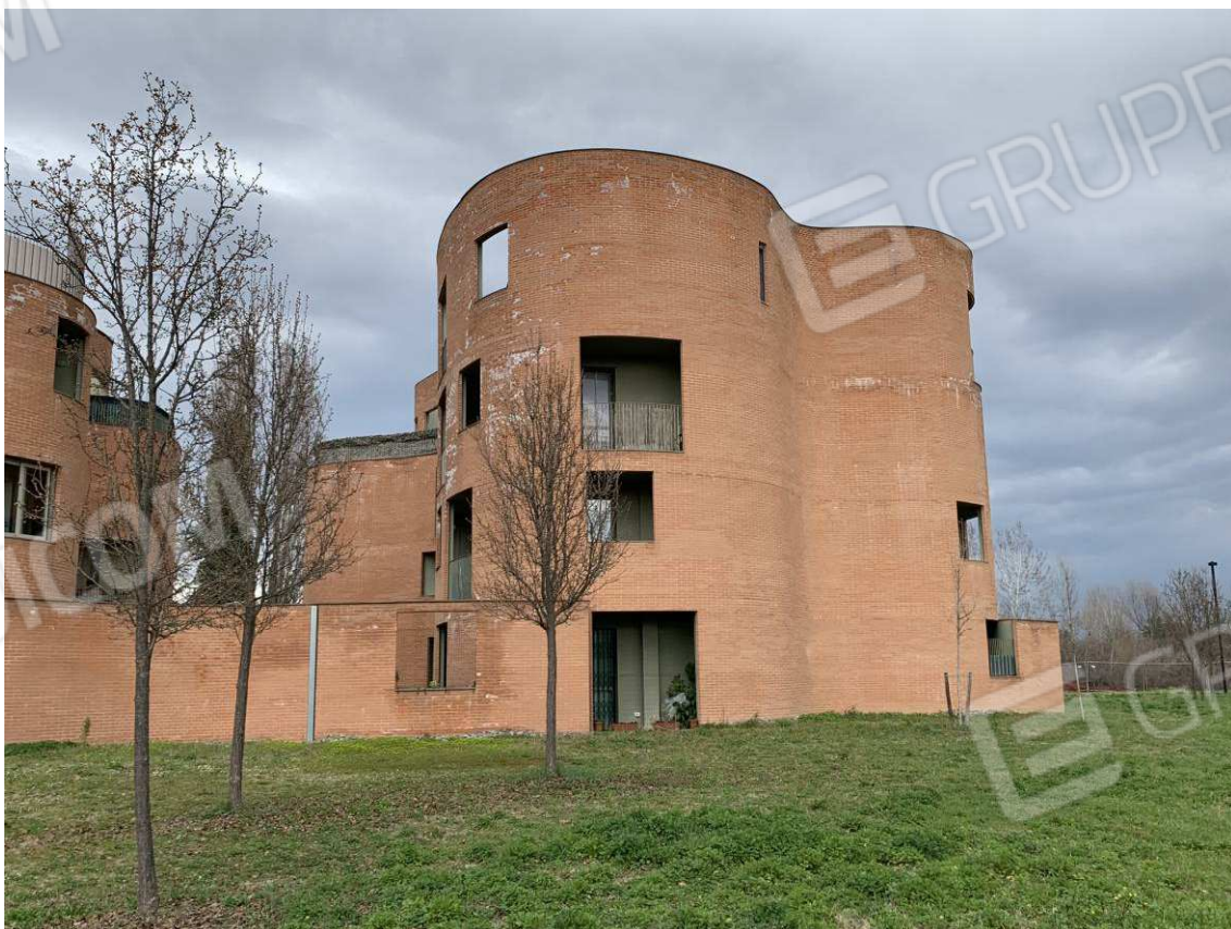
Foto 6: Esterni – Fabbricato B
