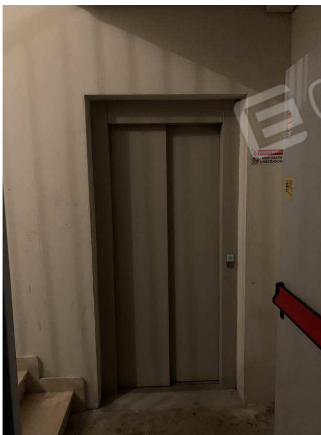
Foto 18: Parti comuni – Fabbricato B
