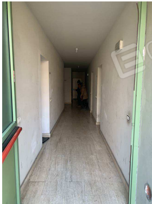
Foto 14: Parti comuni – Fabbricato B
