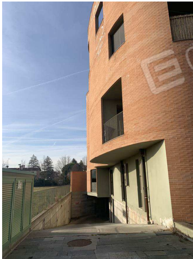
Foto 29: Accesso ai garage – Fabbricato B
