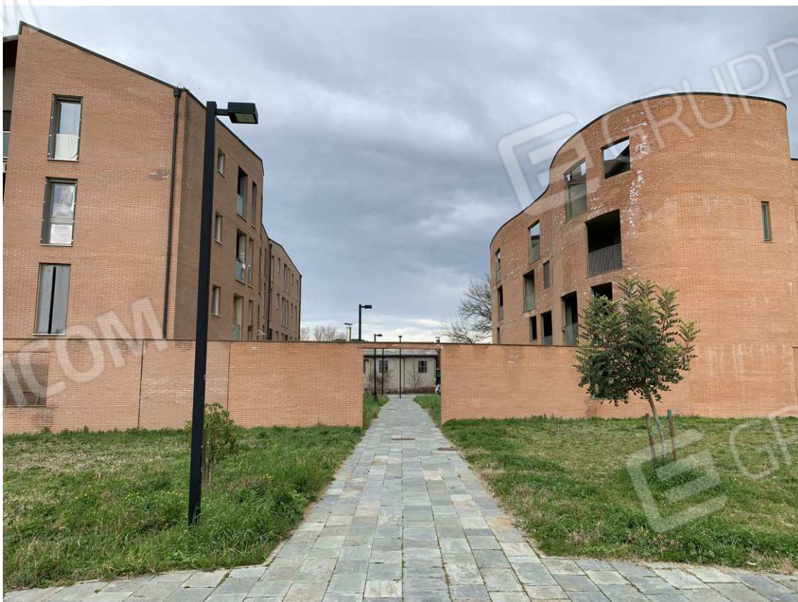
Foto 12: Esterni – area circostante
