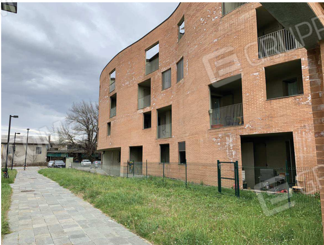
Foto 6: Esterni – Fabbricato A
