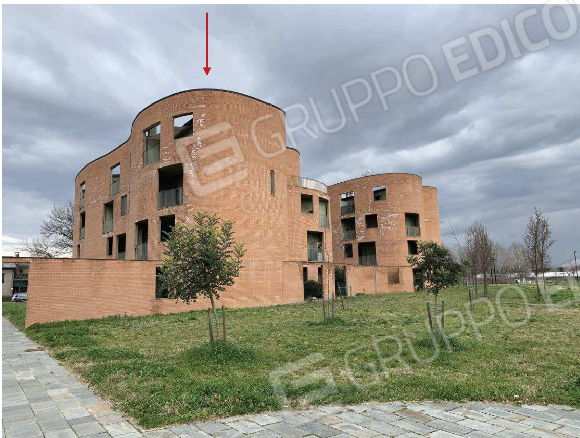
Foto 7: Esterni – Fabbricato A
