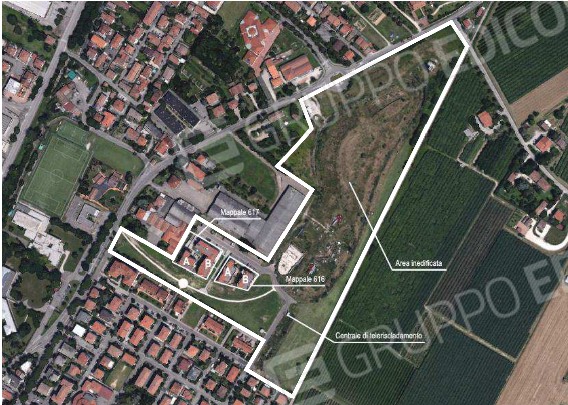
Foto 1: Vista aerea – Perimetro area di interesse
