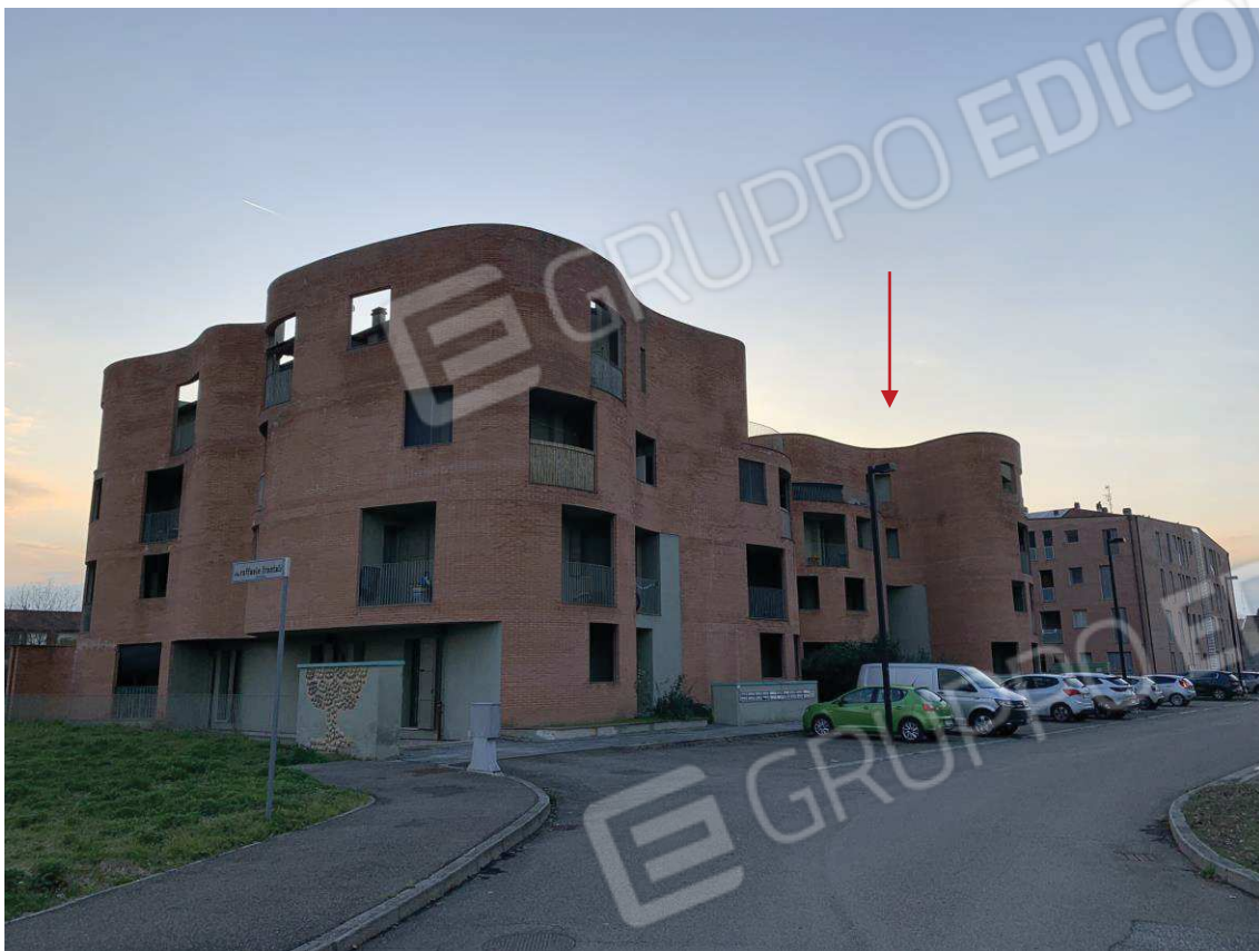
Foto 5: Esterni – Fabbricato A
