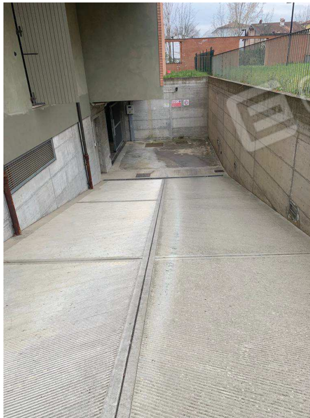
Foto 14: Accesso ai garage – Fabbricato A
