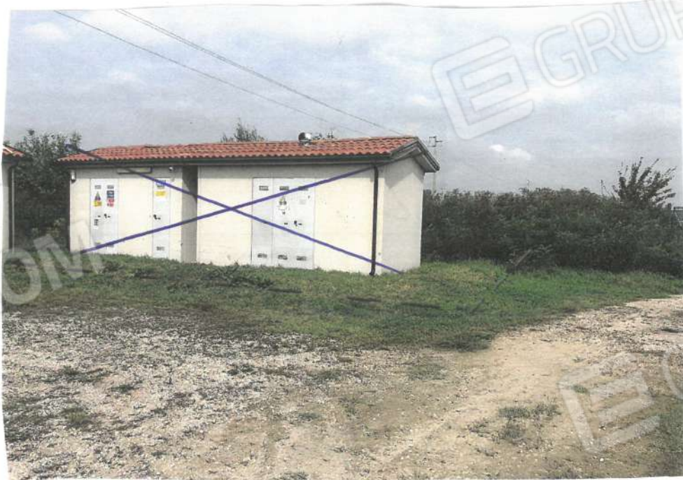
2- VISTA PAPP. 289 E 290, OGGETTO DI PIGNORAMENTO È L'AREA E NON LE SOPRSTANTI CABINE ELETTRICHE
