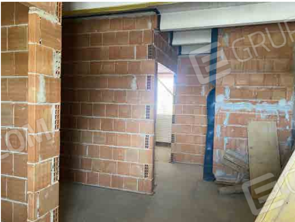
Foto 6 interno alloggio al grezzo
