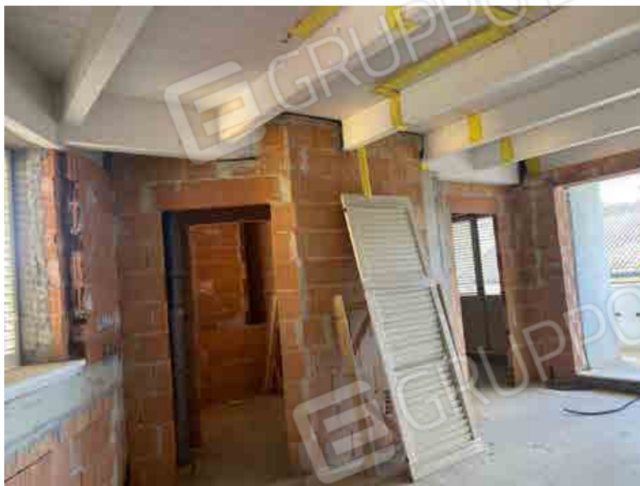
Foto 7 interno alloggio al grezzo
