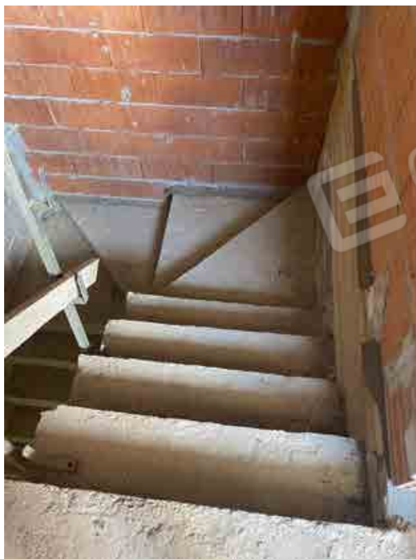
Foto 8 scala interna al grezzo
