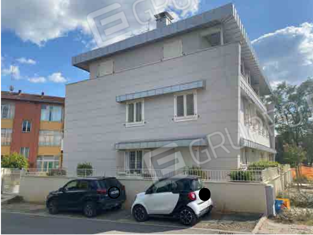
Foto 1 fronte edificio condominiale
