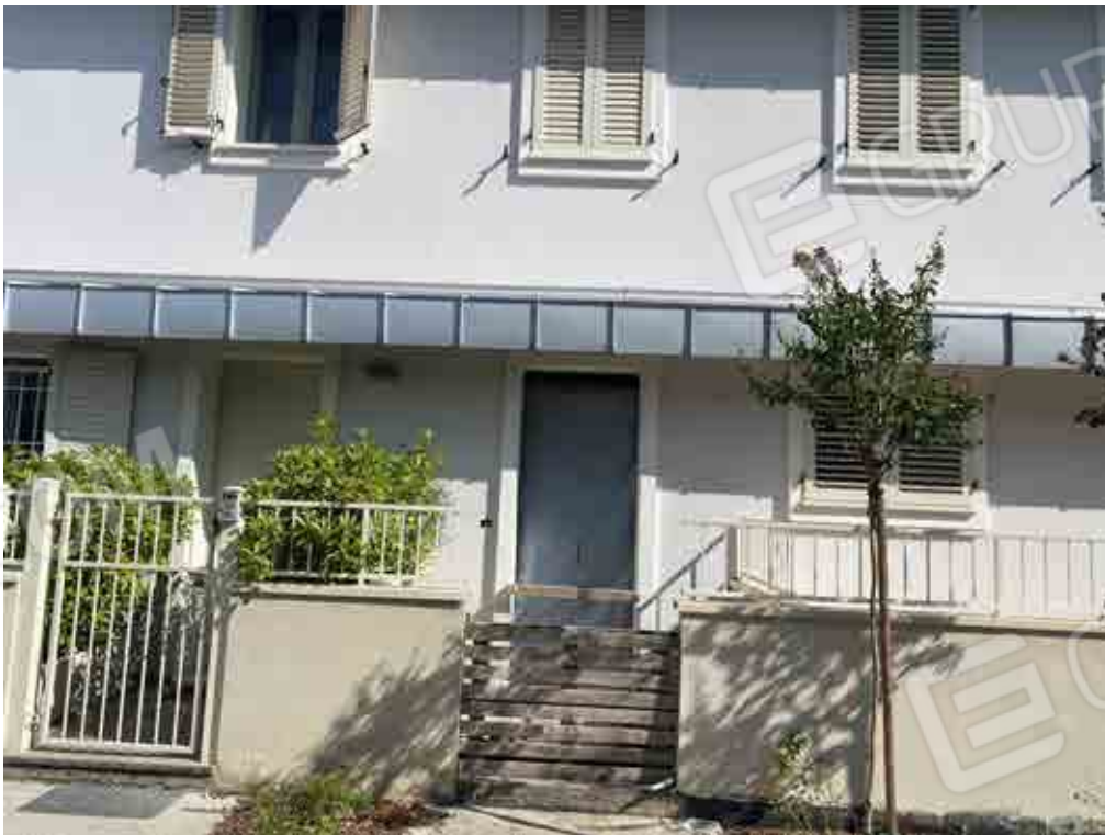
Foto 2 ingresso all'unità immobiliare
