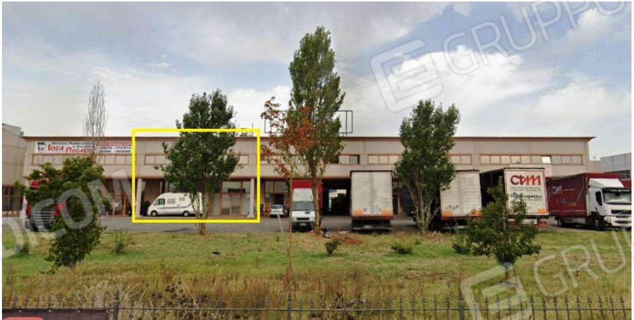
VISTA PROSPETTO SUD DEL COMPLESSO "GIULIO CESARE" DALLA VIA BOLLANA E INDICAZIONE DELL'UNITA' IN OGGETTO
