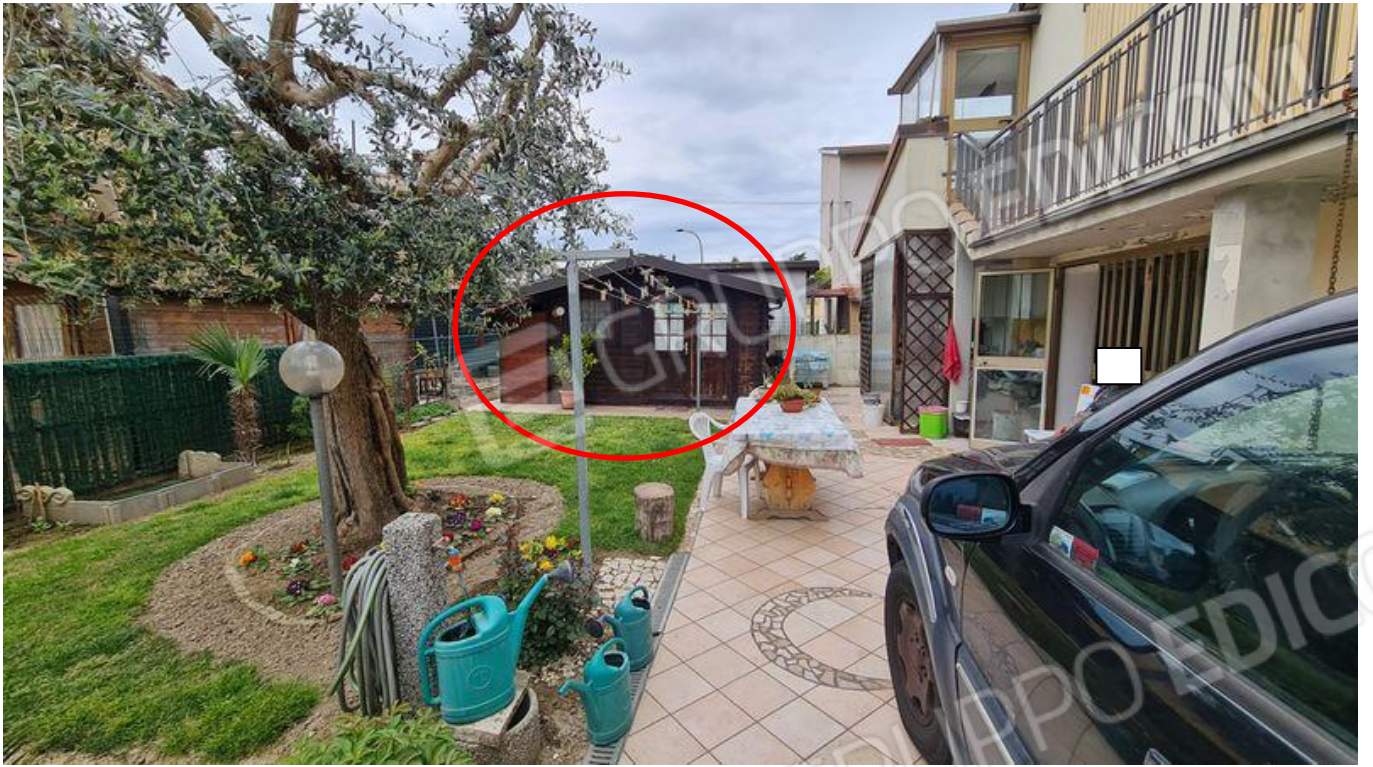
Deposito in legno non autorizzato (PT)
