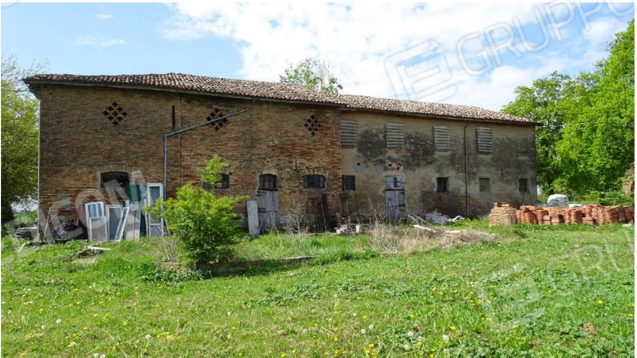
Foto 06_prospetto principale retro
