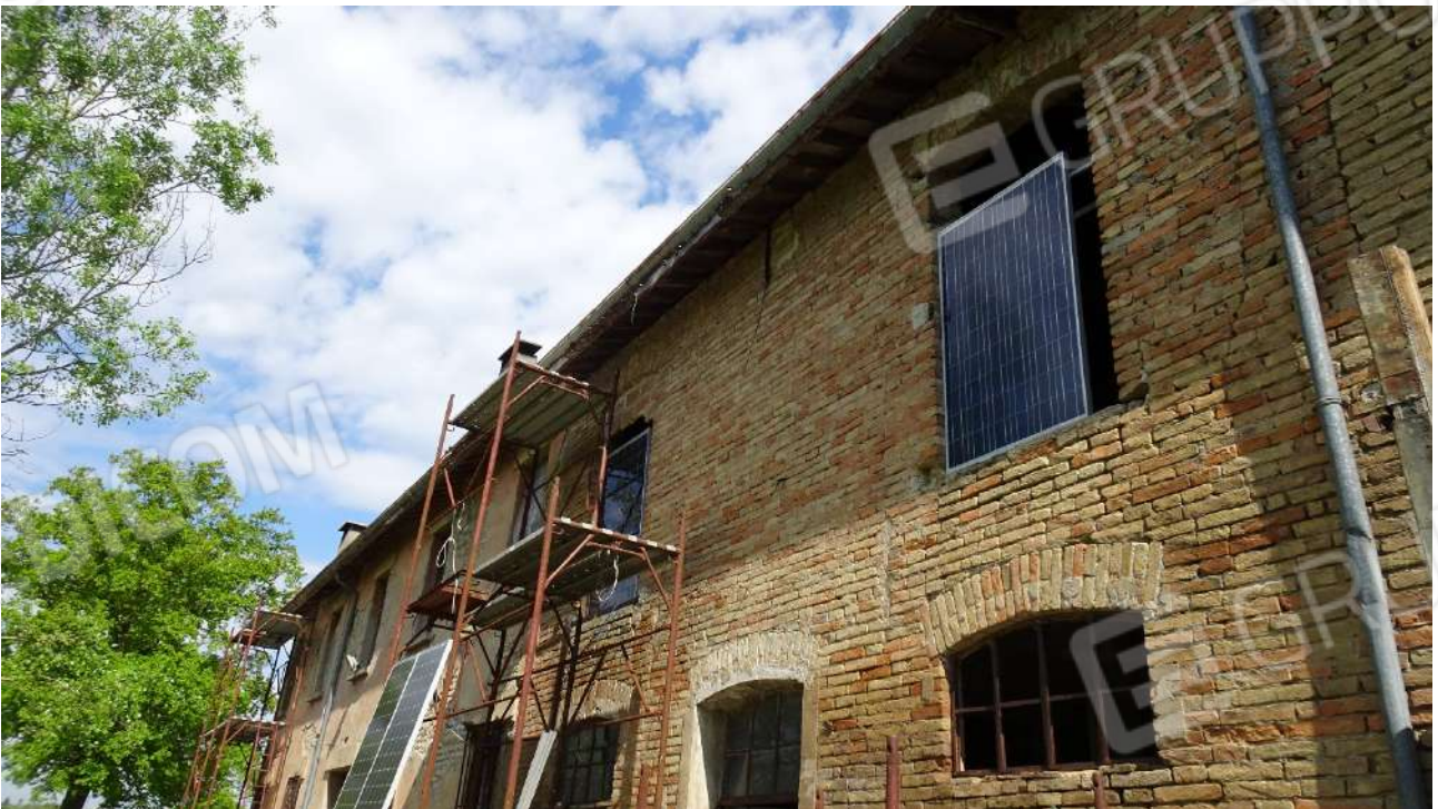
Foto 02_particolare prospetto principale
