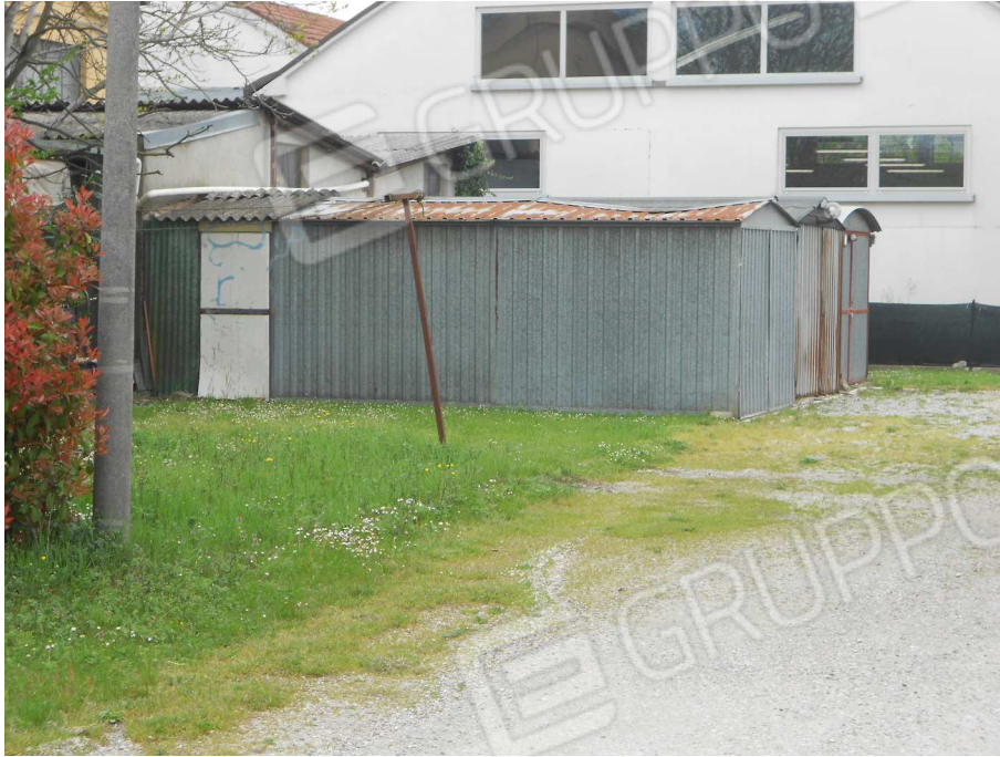
Box in lamiera su area condominiale
