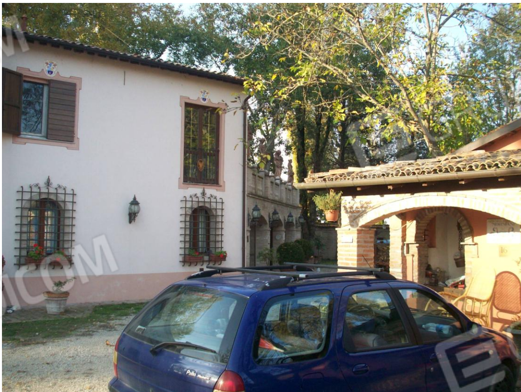
FOTO 6 – PARTICOLARI FABBR. “B” E FABBR. “C”
