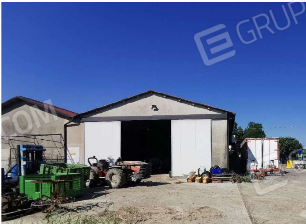
Vista esterna capannone (F.127 Part.206 Sub.5)
