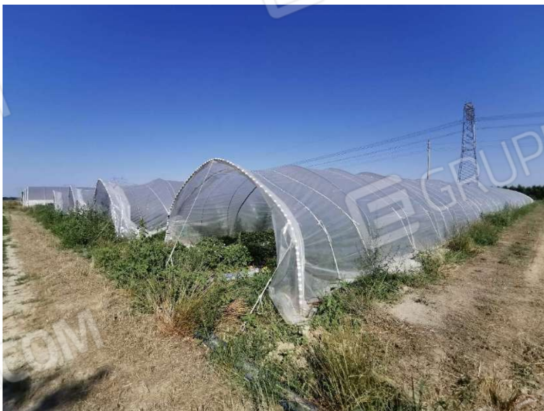
Vista esterna serre stagionali (F.127 Part.786)
