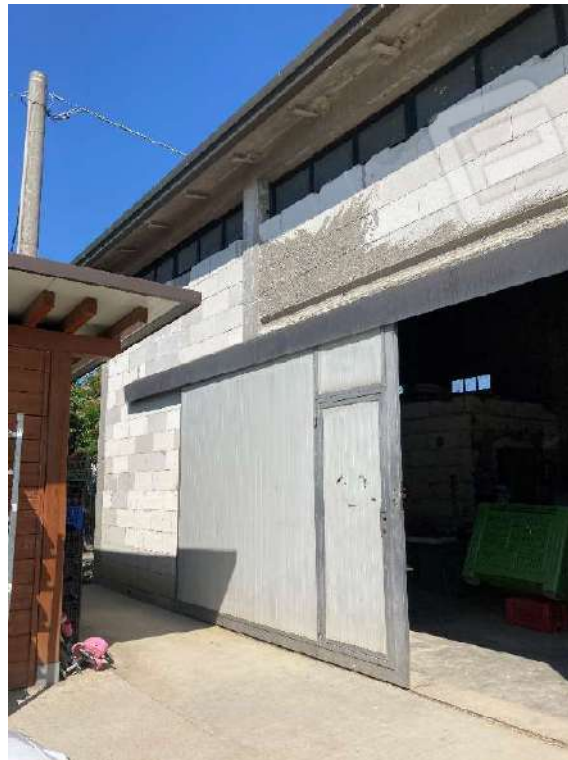
Vista esterna interna ricovero attrezzi agricoli (F.127 Part.206 Sub.5)
