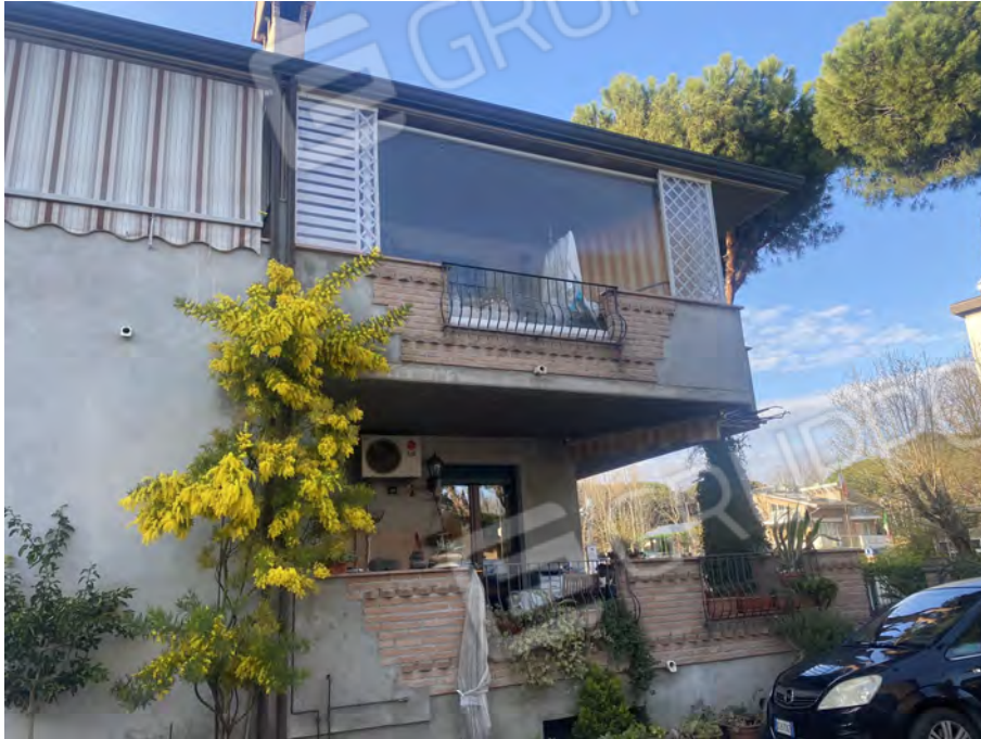
Foto 1 esterno lato sud
