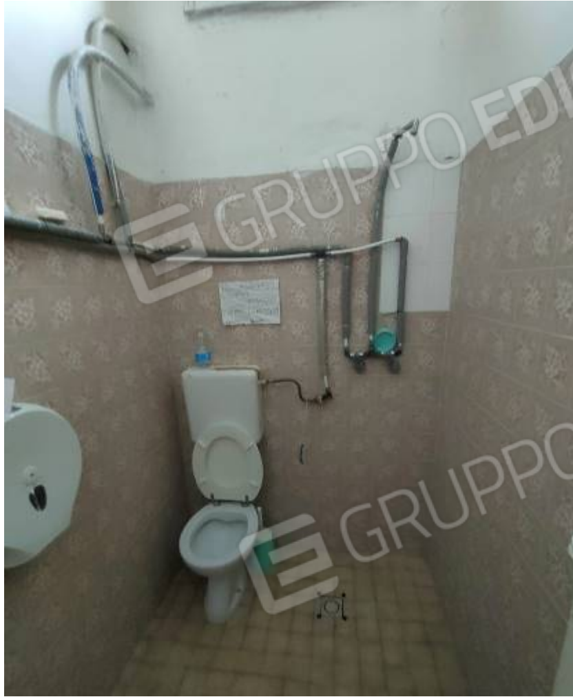
Vista interna del bagno
