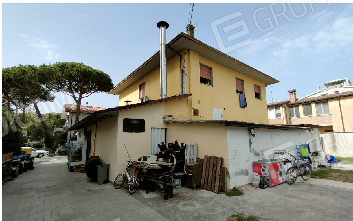
Vista lato sud-ovest del fabbricato ed in particolare del laboratorio al piano terra
