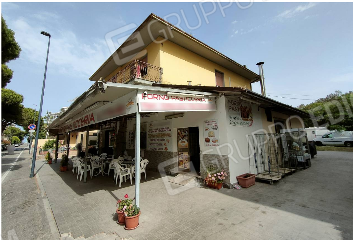
Vista lato nord-ovest del fabbricato, in particolare del laboratorio e negozio al piano terra
