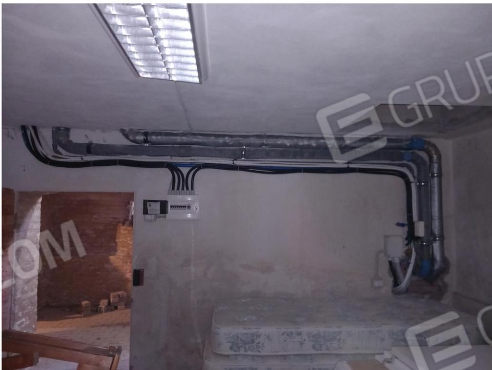
Foto n. 14 - Vista della pompa di calore ad alimentazione elettrica e relativo quadro posto al piano seminterrato nella cantina di pertinenza
